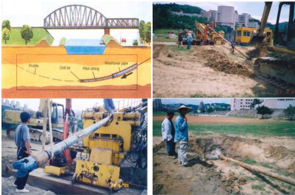
圖 4-6 導孔鑽掘施工圖
