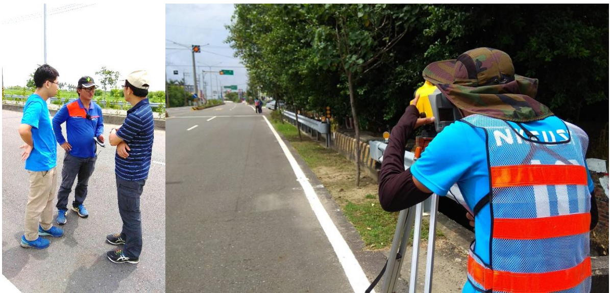
圖 3-16 輸水路線定線測量過程
