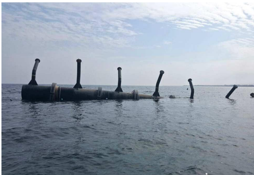
圖 3-1 多孔排放設施示意圖（僅供參考）
