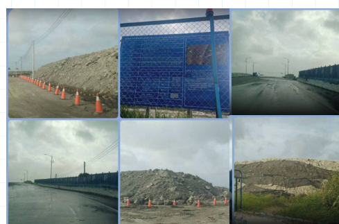
7/10 通報當日現況照片
