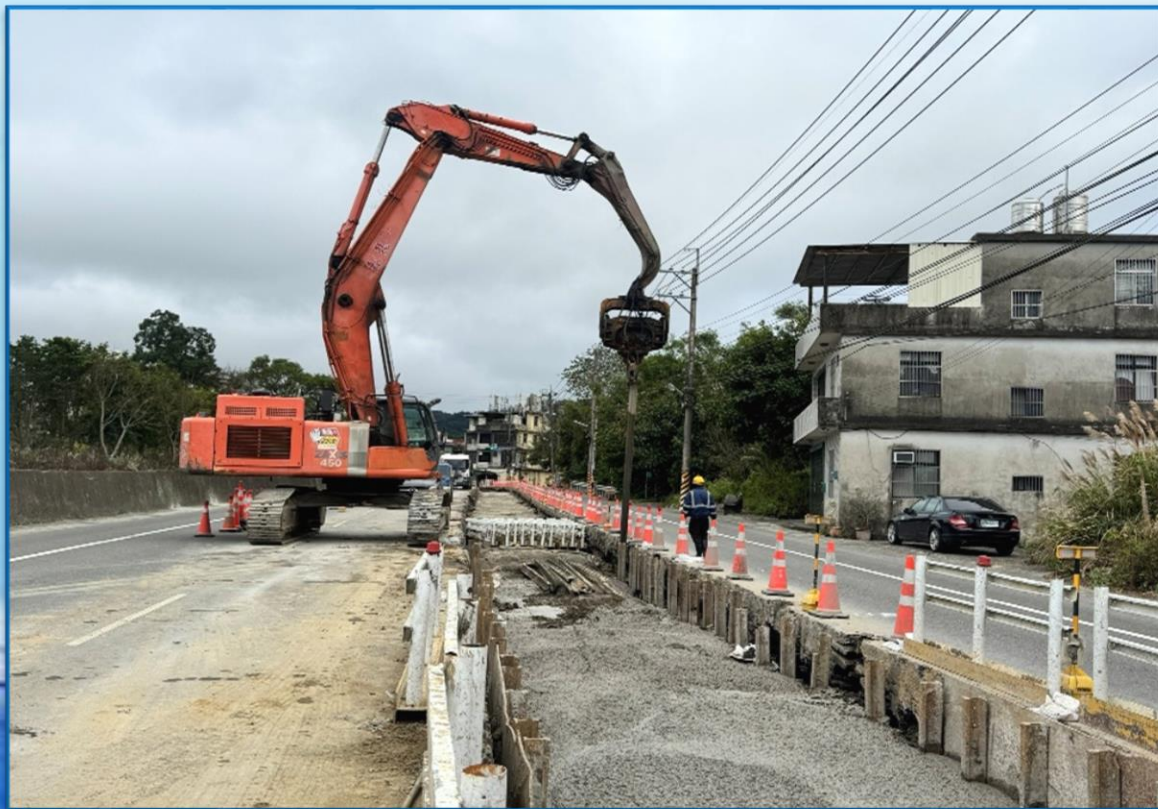
第三工區鋼軌樁拔除
