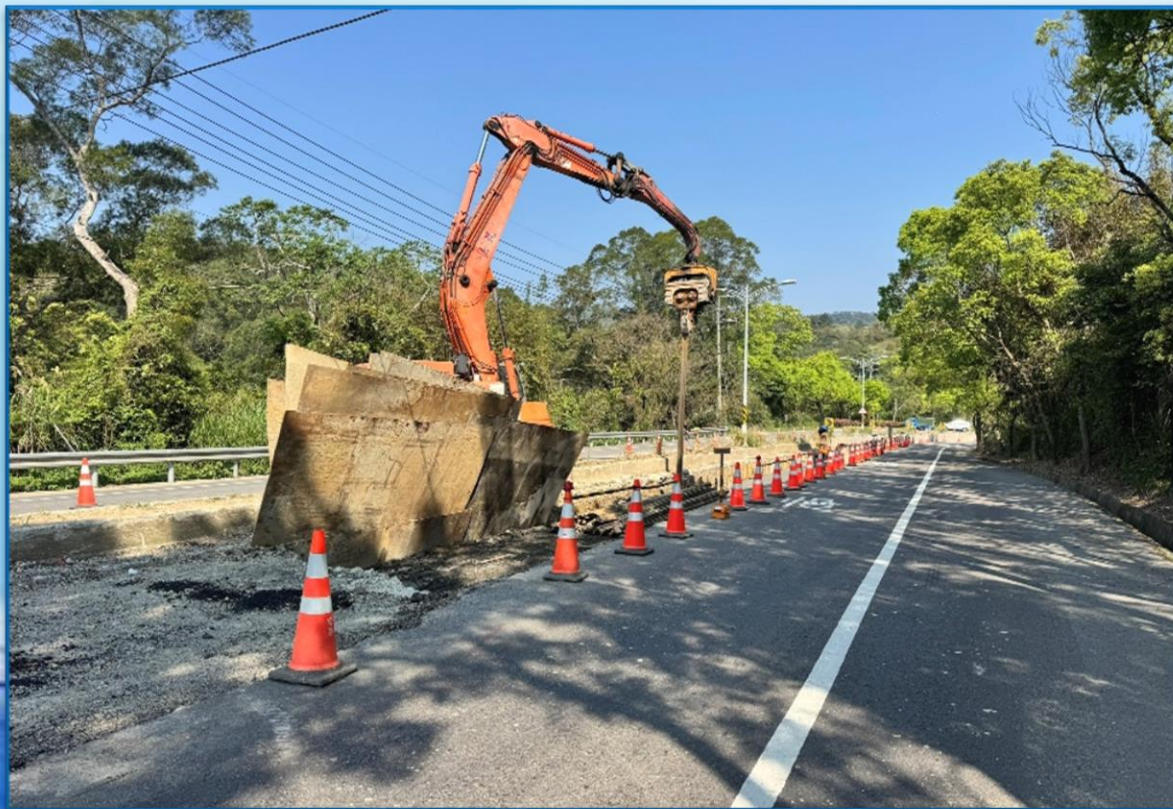
第四工區氣動錘鑽掘
