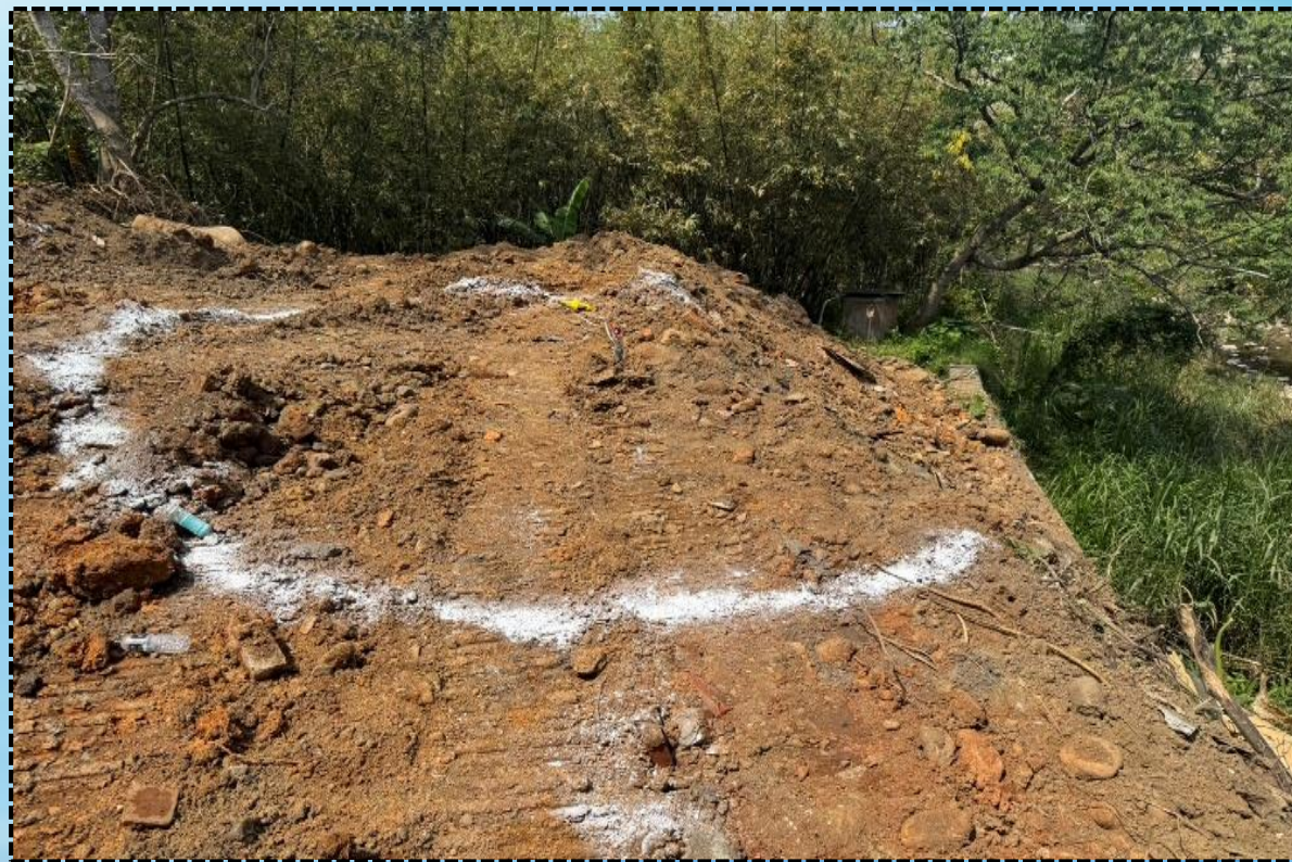
關西二號橋A2橋台整地
