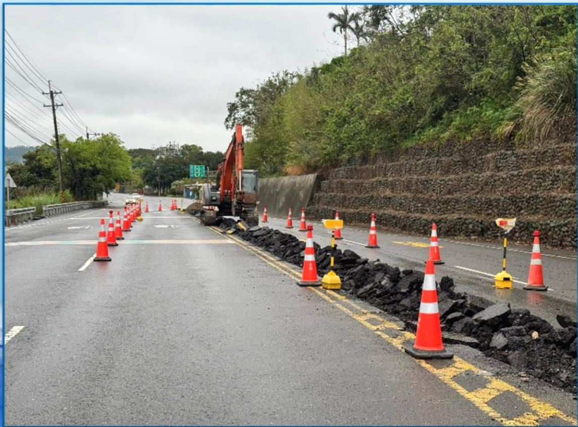
第一工區導溝挖掘
