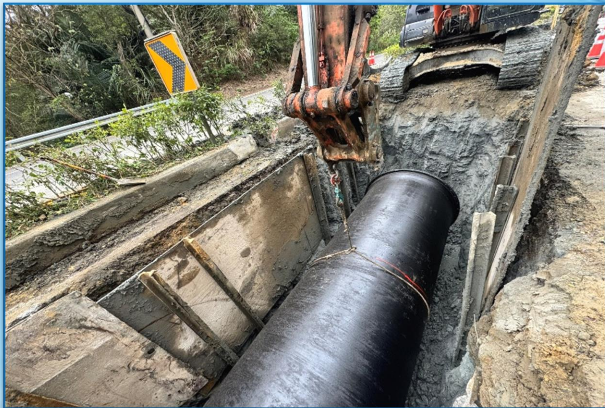
第四工區管線埋設
