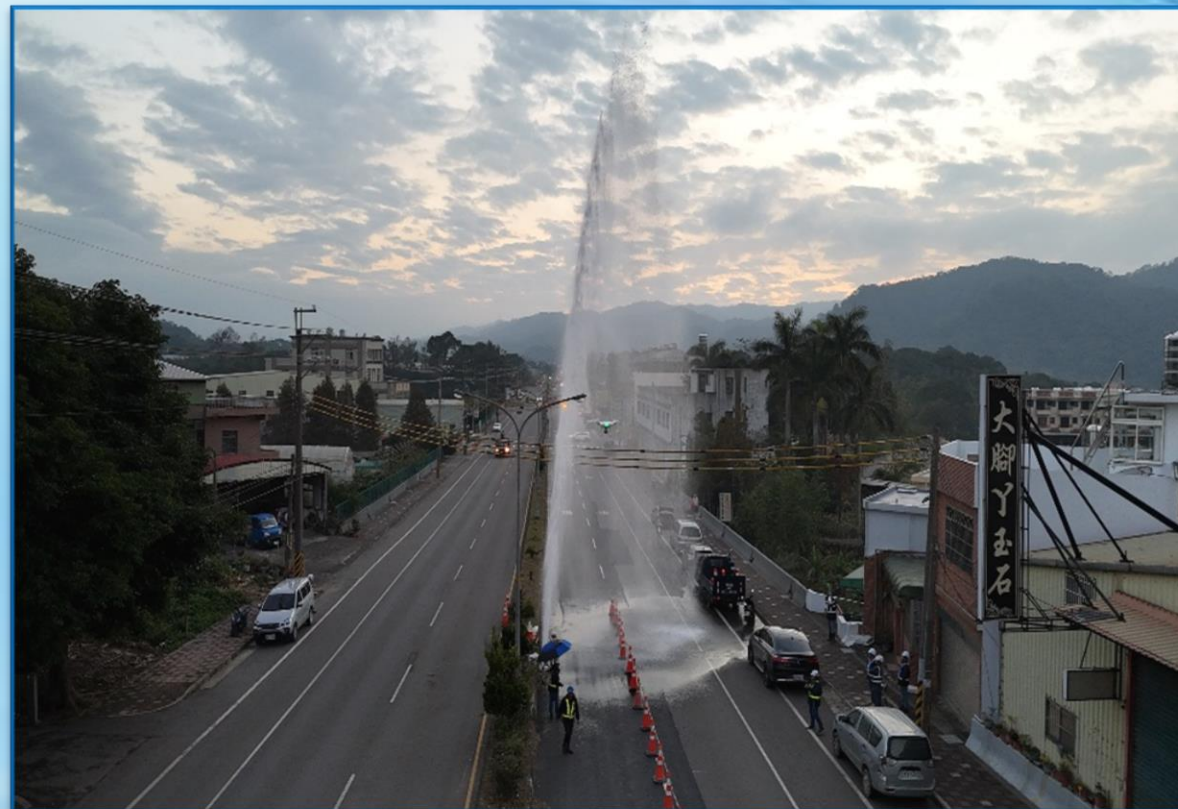
第二工區水壓測試
