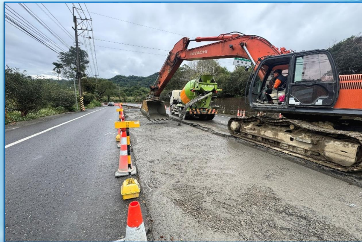
第三工區CLSM回填澆置
