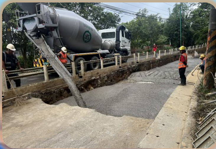
明挖段第一工作面: CLSM澆置
