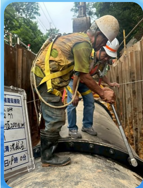
明挖段第一工作面: DIP埋設
