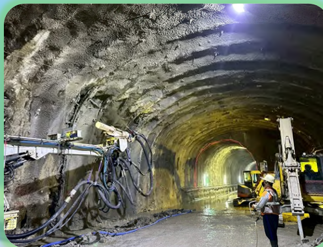
隧道段:斷面入侵修改噴漿作業
