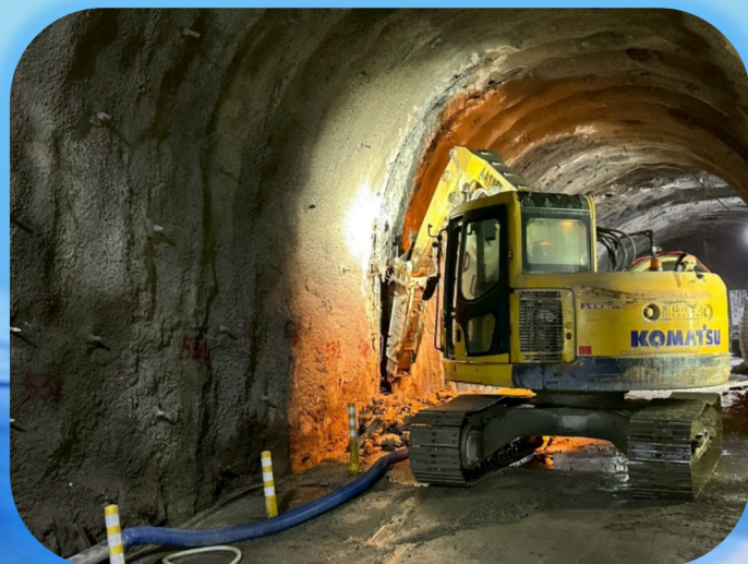
隧道段:斷面入侵修改
