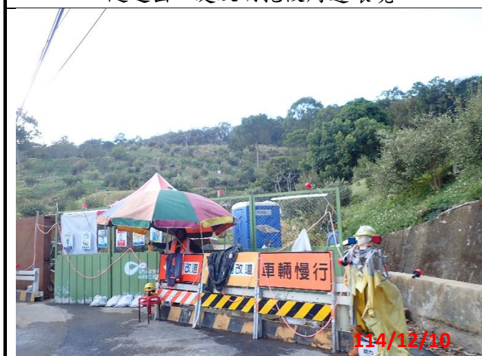
隧道出口處及明挖段周邊環境
