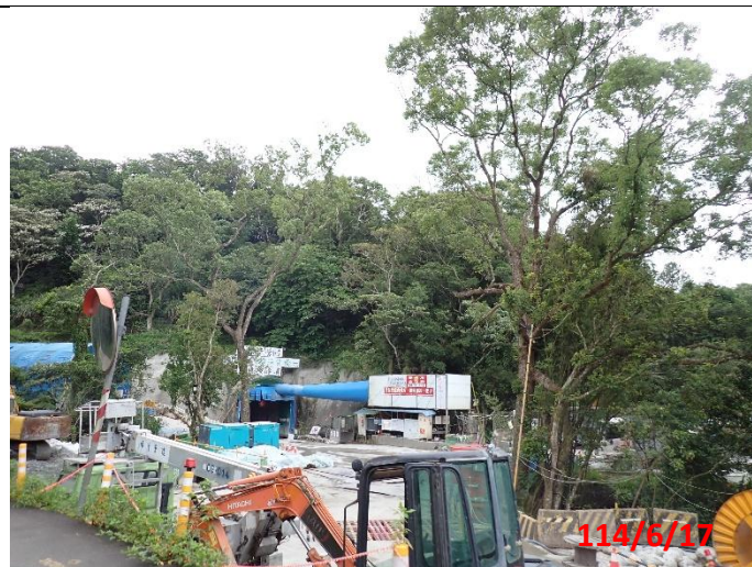
隧道出口處及明挖段周邊環境
