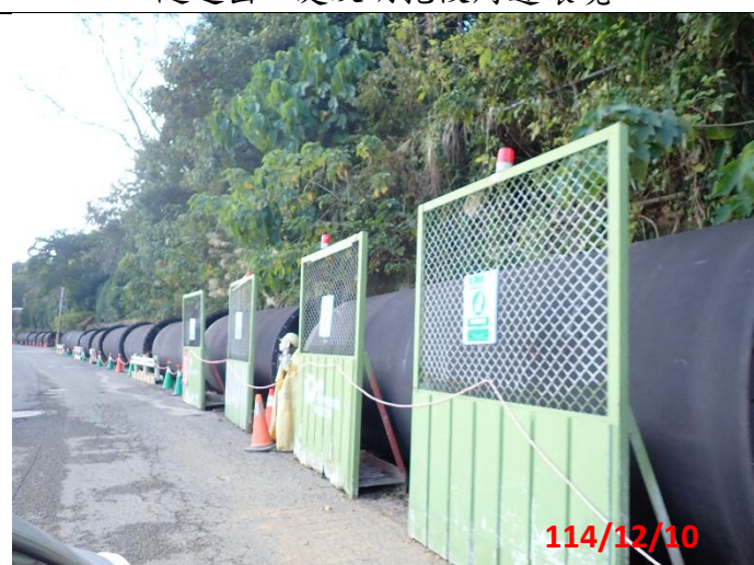
隧道出口處及明挖段周邊環境
