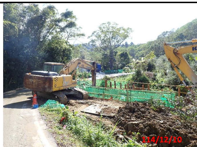
隧道出口處及明挖段周邊環境
