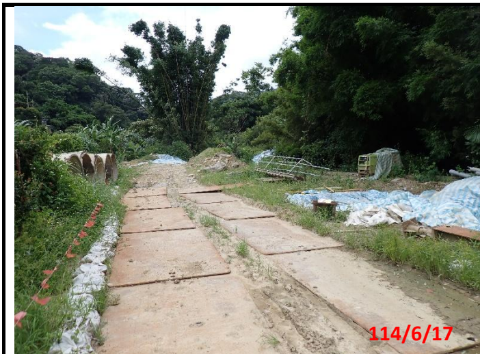
隧道出口處及明挖段周邊環境
