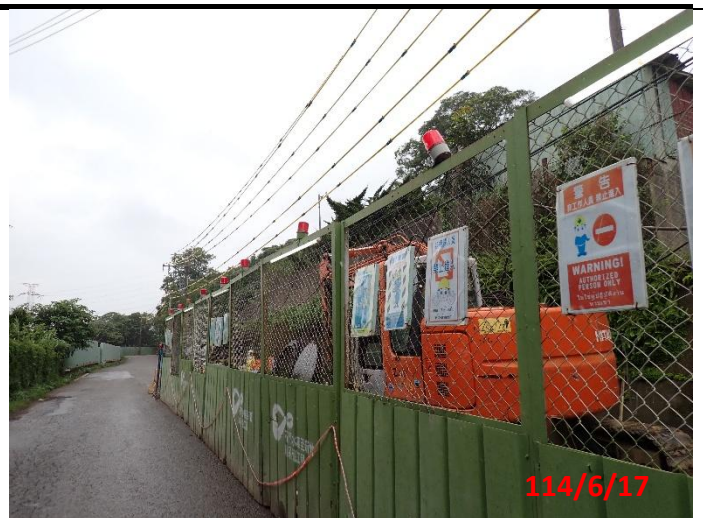
隧道出口處及明挖段周邊環境
