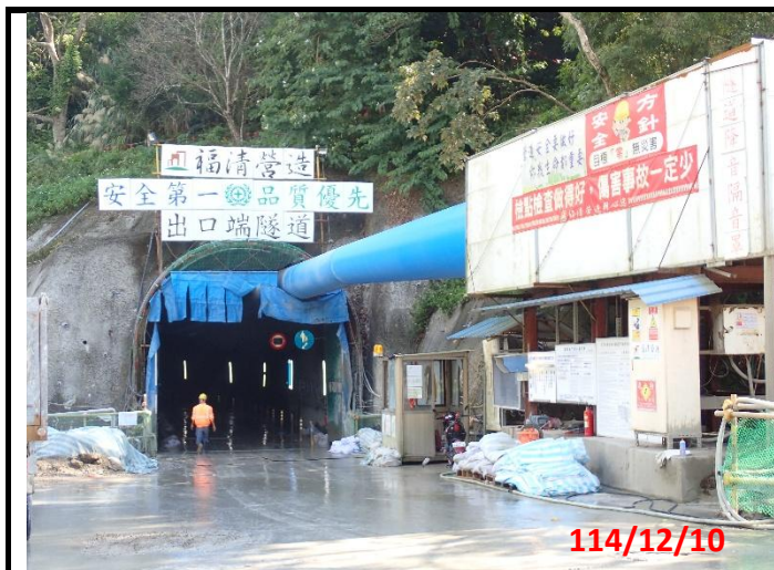
隧道出口處及明挖段周邊環境
