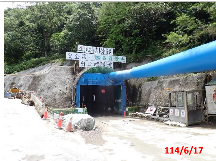
隧道出口處及明挖段周邊環境
