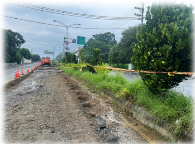
植生警示帶標示及警示錐 既有植生施工損壞採補植辦理
