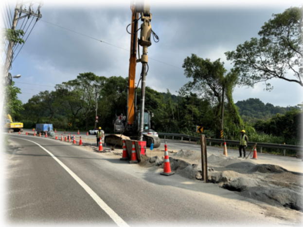
氣動錘工法加圓鐵桶 減噪&防止塵土四散
