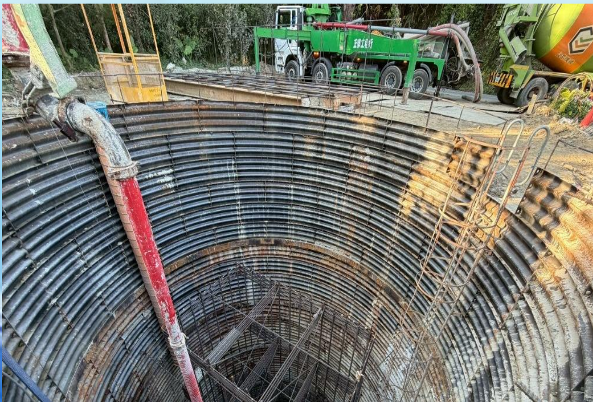
北沙坑水管橋A1橋台井式基礎澆置
