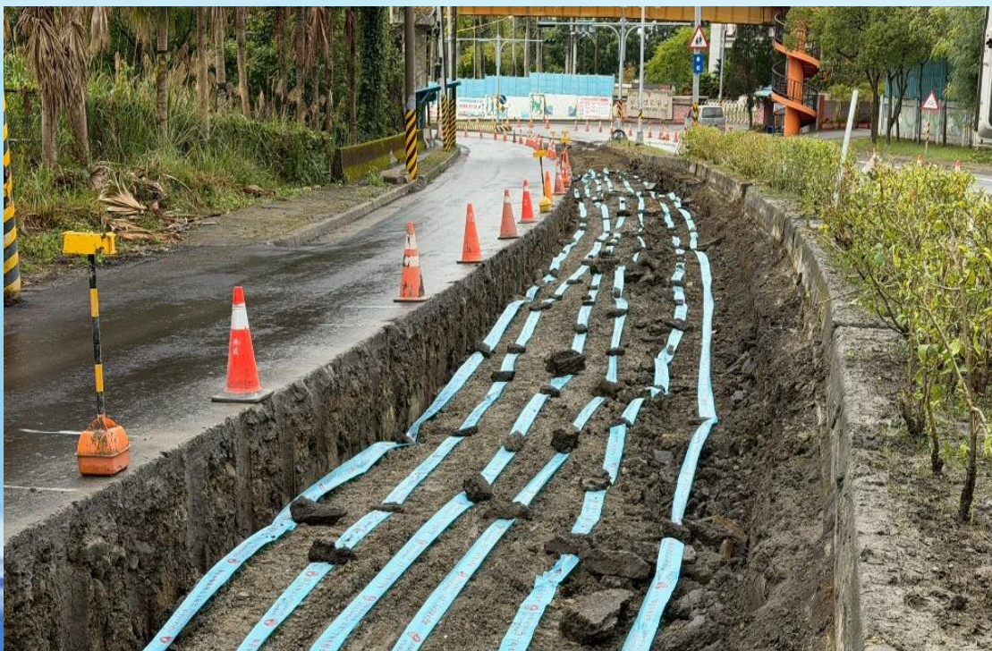
第五工區警示帶鋪設
