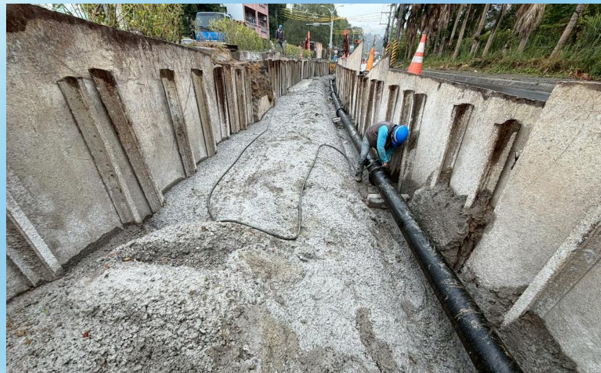
第五工區自來水管安裝
