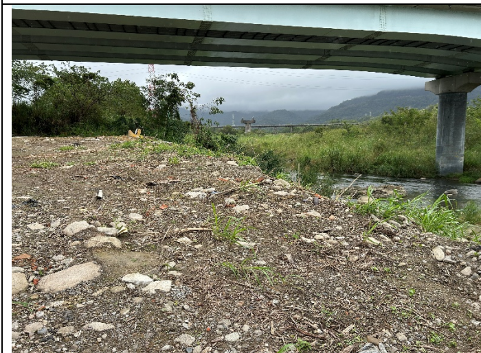
施工影響範圍現況
