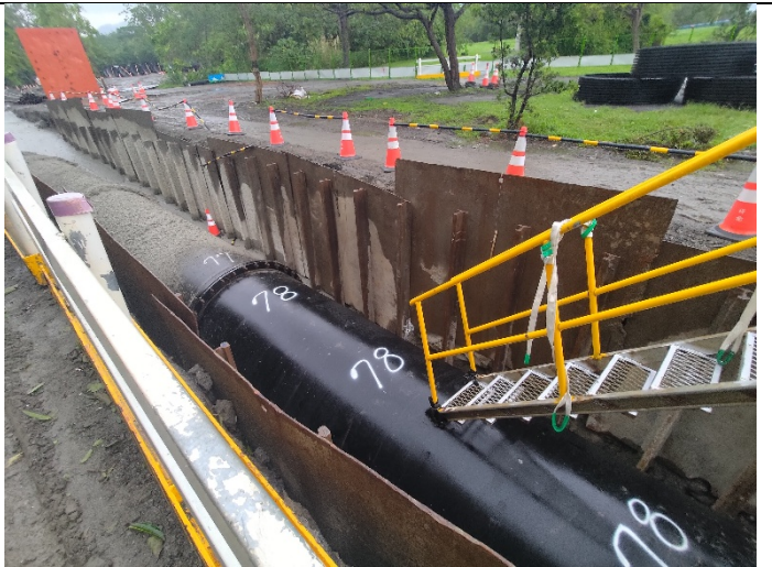
施工影響範圍現況
