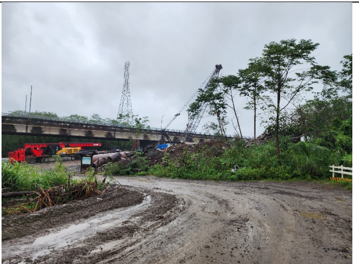
施工影響範圍現況
