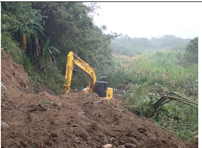
施工影響範圍現況
