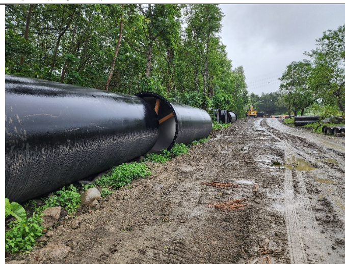
施工影響範圍現況
