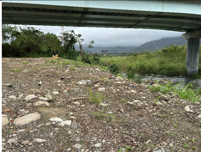
施工影響範圍現況
