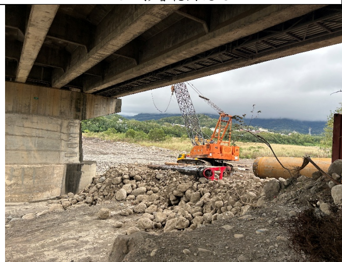
施工影響範圍現況
