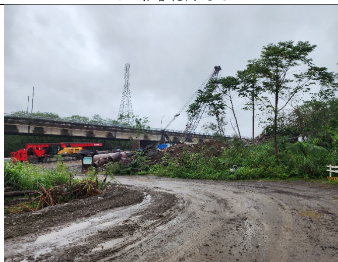
施工影響範圍現況
