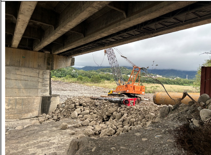
施工影響範圍現況
