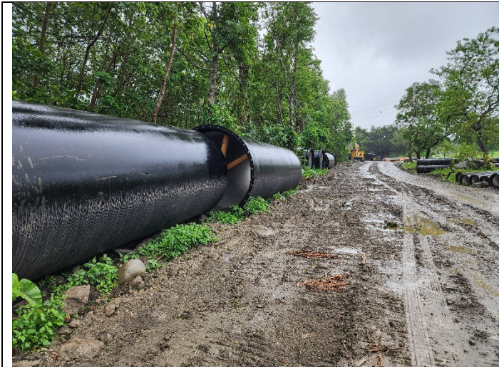
施工影響範圍現況
