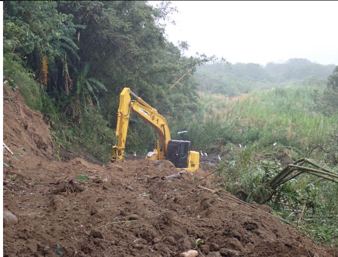
施工影響範圍現況
