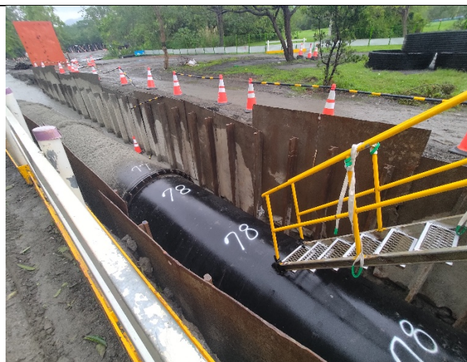
施工影響範圍現況
