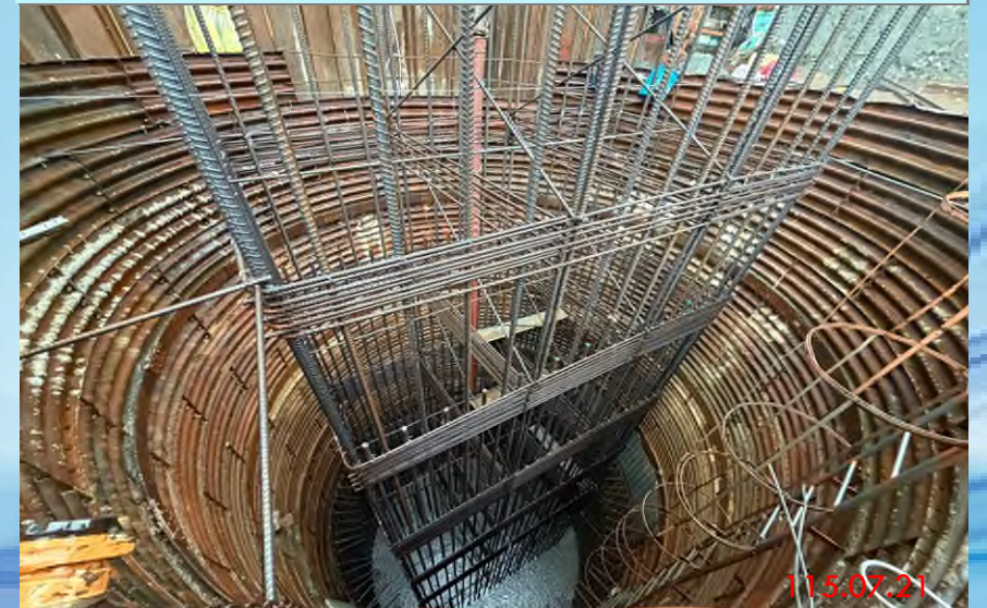
南華水管橋A1橋台混凝土澆置
