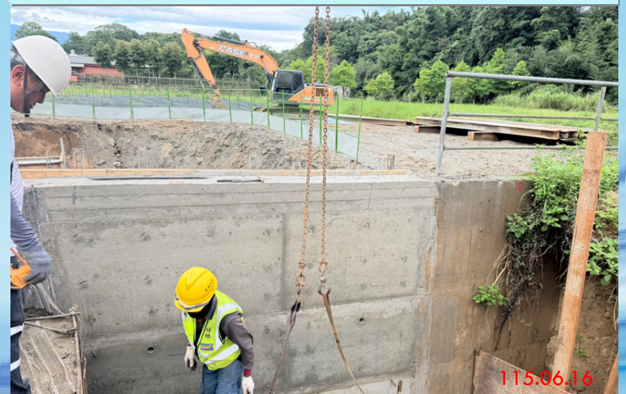
芴子園橋河底管護岸復舊
