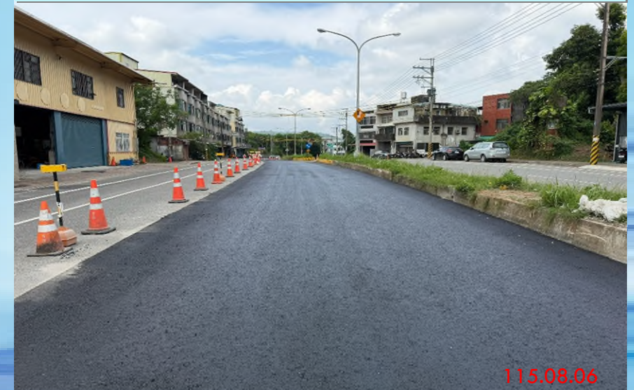
第一工區AC鋪設
