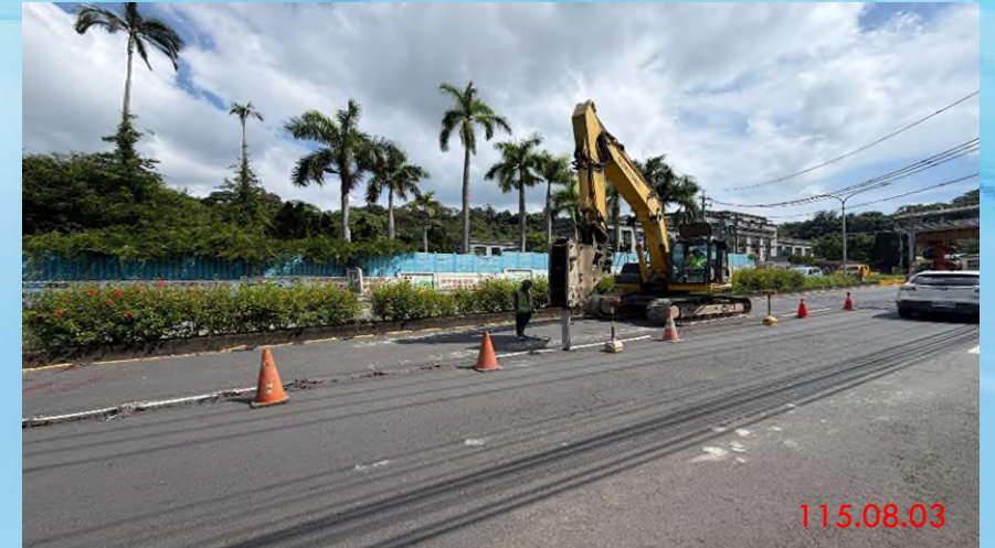
第五工區鋼軌樁打設
