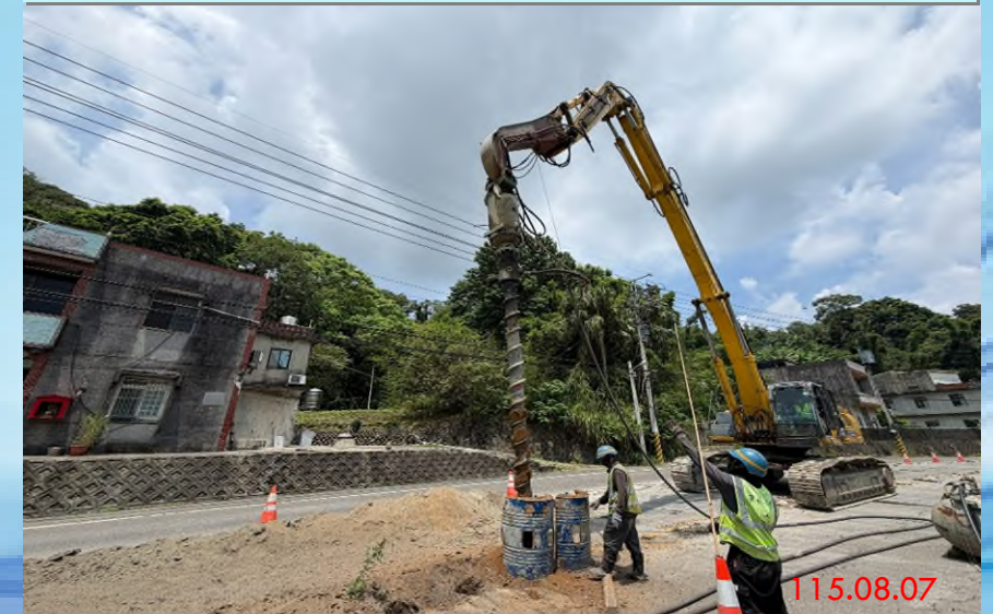
第三工區鋼軌樁打設
