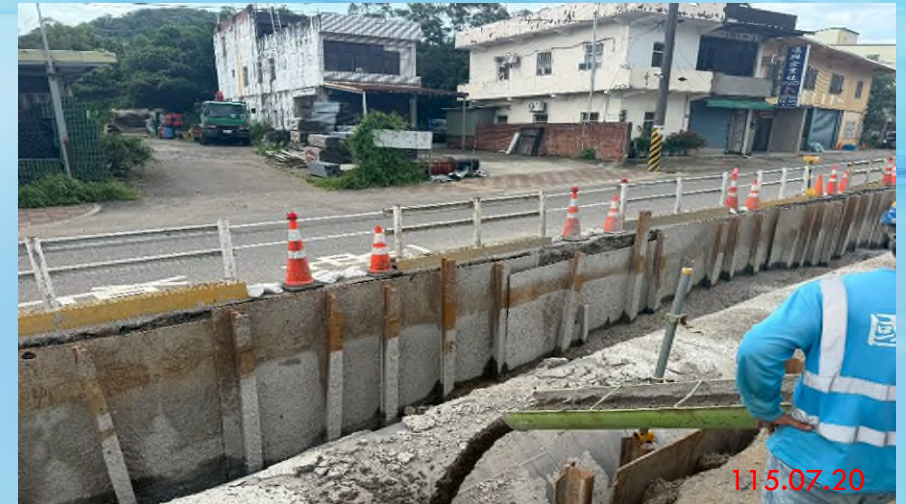
第一工區管溝CLSM澆置
