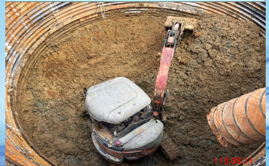
北沙坑水管橋A2橋台基礎開挖
