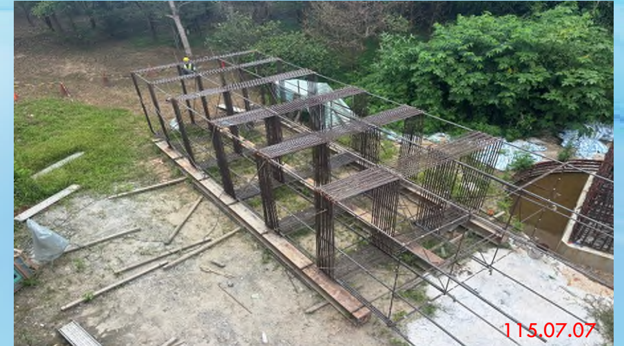
南華水管橋A2橋台鋼筋綁紮
