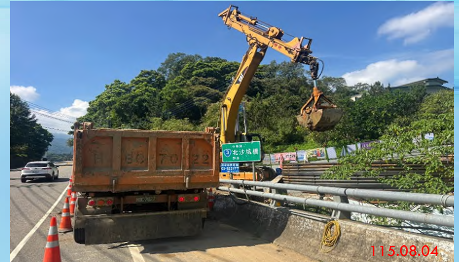
北沙坑水管橋A2橋台基礎開挖
