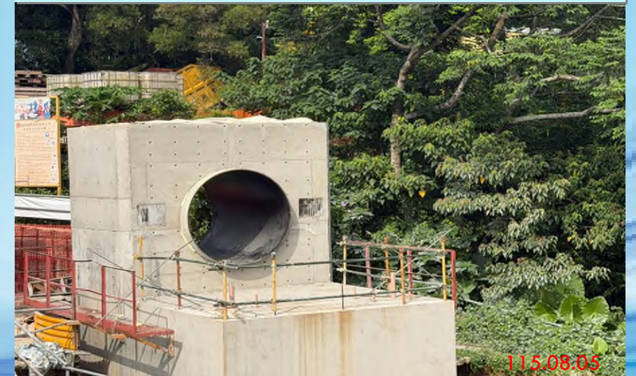
關西二號橋A2橋台鋼管吊裝
