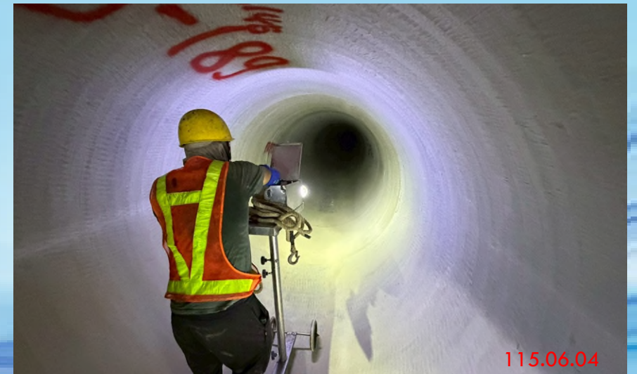
W02→W03推進管內CCTV檢視作業
