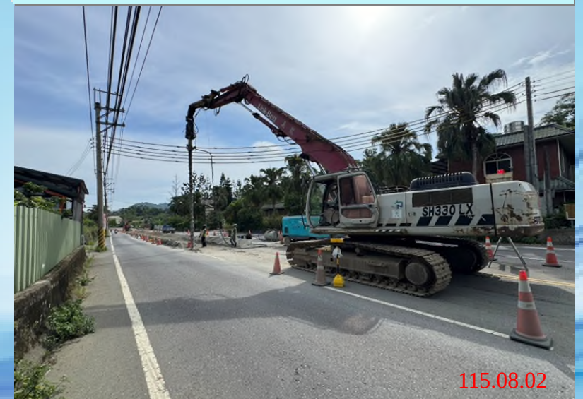
第二工區鋼軌樁打設
