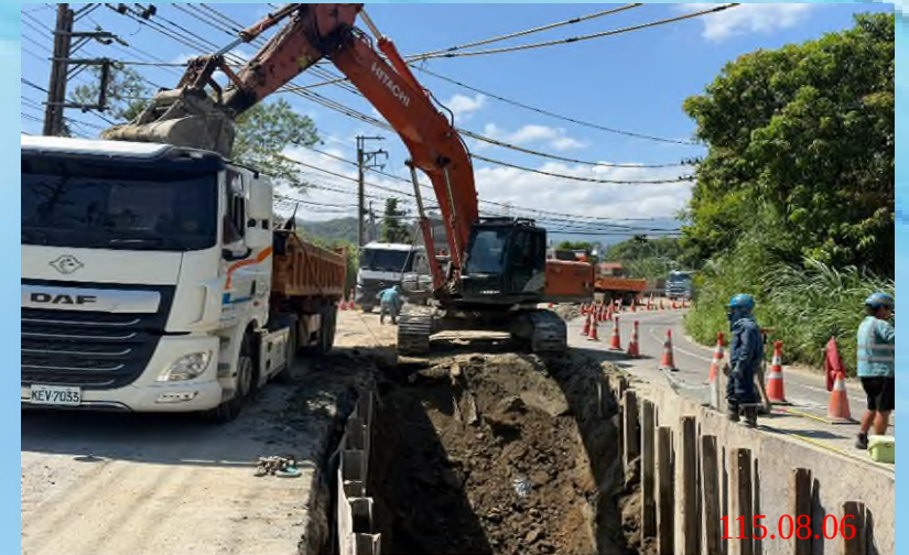
第二工區路面開挖
