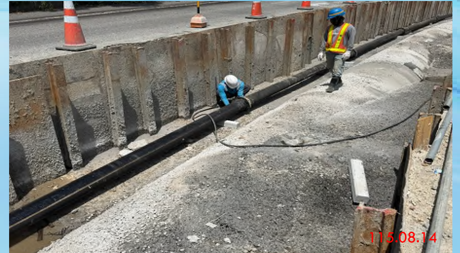
第三工區自來水管埋設
