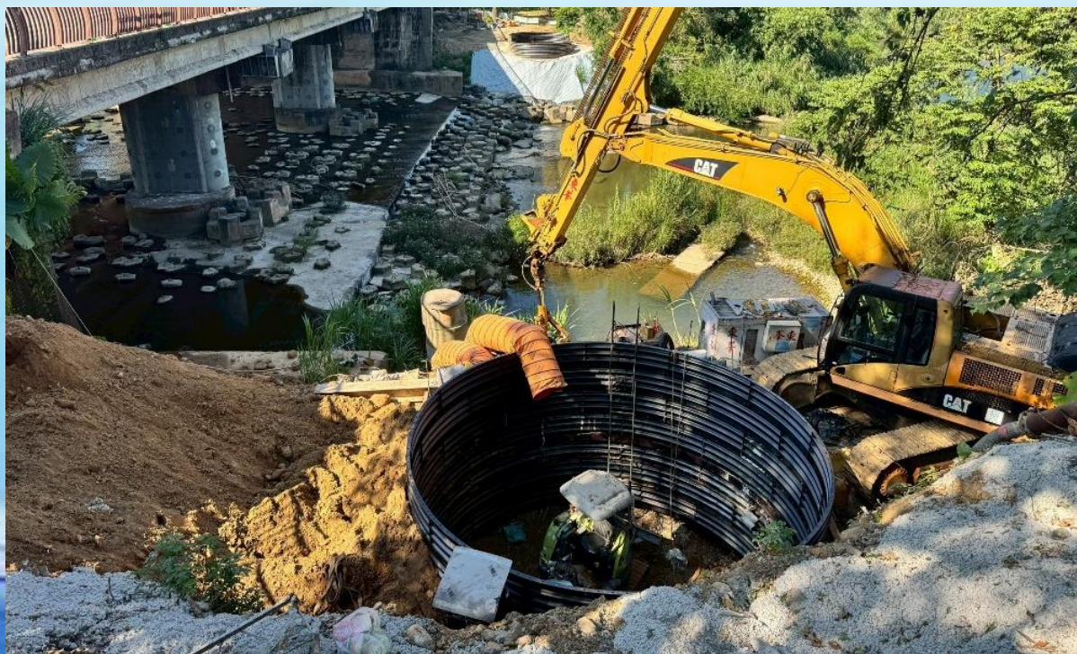
南華水管橋A1橋台井式基礎開挖
