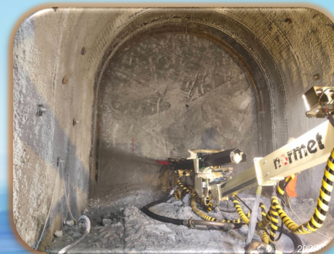
出口一般段: 出口端隧道噴漿作業
