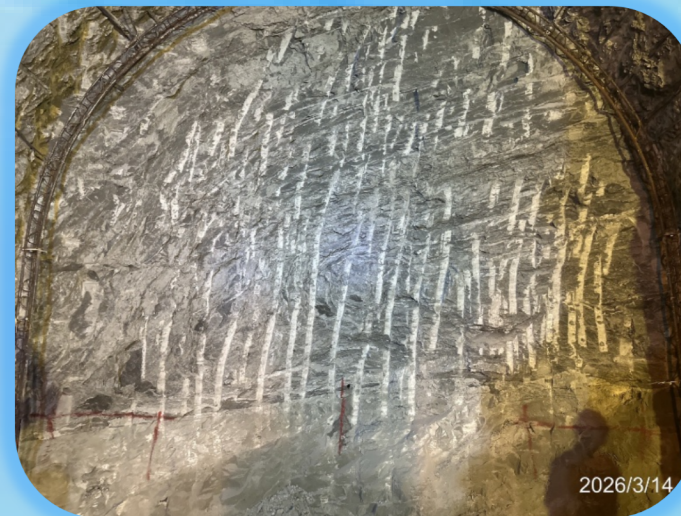
進口一般段: 進口端隧道NT-1051開挖面照
