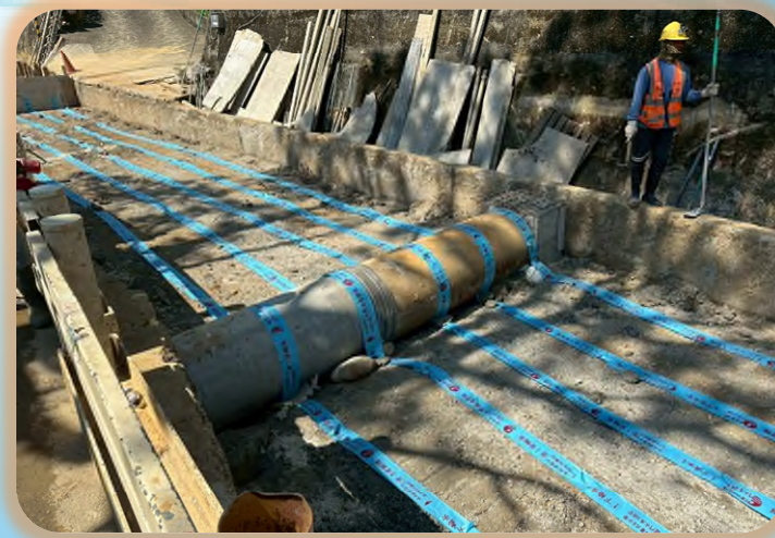
明挖段一工區: 警示帶鋪設
