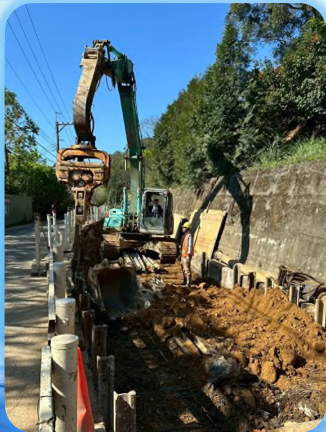
明挖段一工區: 鋼軌樁引孔打設
