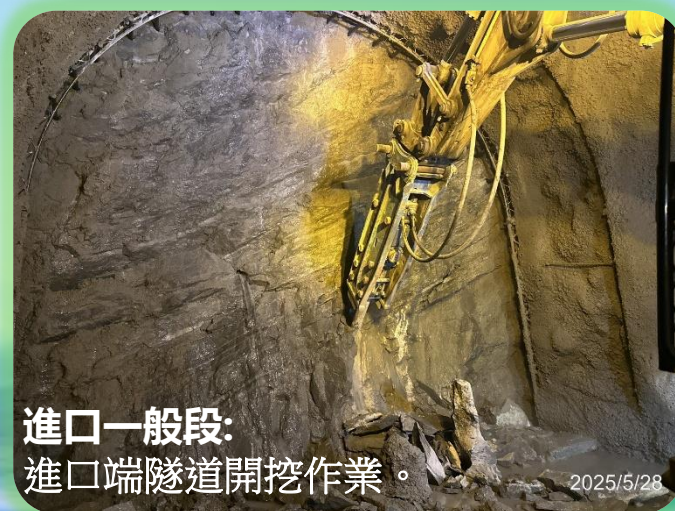
進口一般段： 進口端隧道NT-692開挖面照。 2025/5/28
