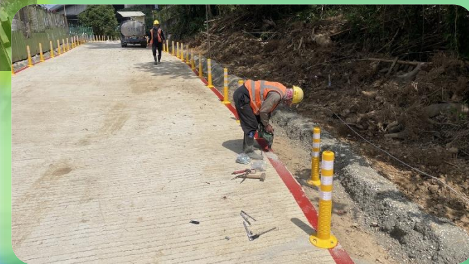
明挖段： 標線施作及防撞桿安裝。
