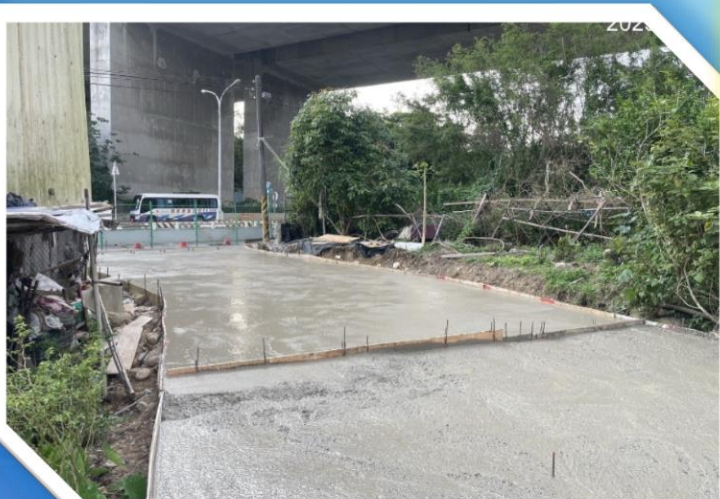
明挖段： 替代道路澆置。
