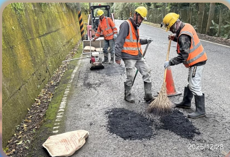
明挖段: 竹28-1道路AC臨補
