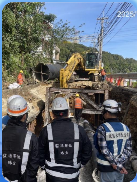
明挖段: DIP開挖埋管
