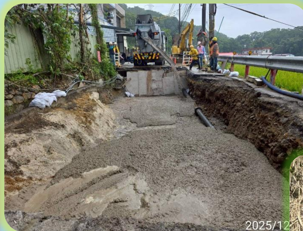
明挖段: CLSM澆置
