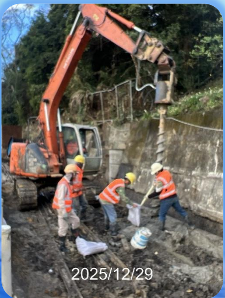
明挖段: 鋼軌樁引孔打設
