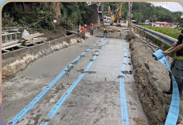
明挖段: 警示帶鋪設
