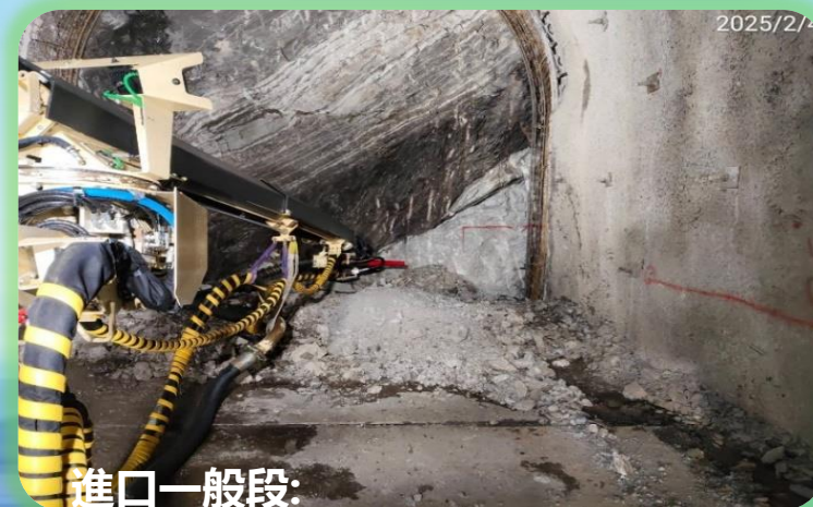
進口一般段： 進口端隧道NT-595開挖面照。
