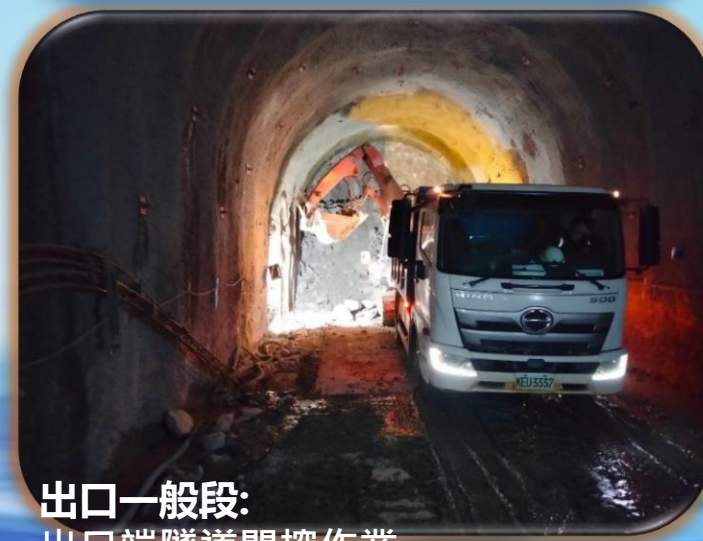
出口一般段: 出口端隧道ST-500開挖面照。
