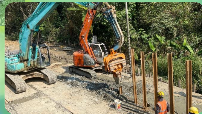
明挖段： 鋼板樁打設。
