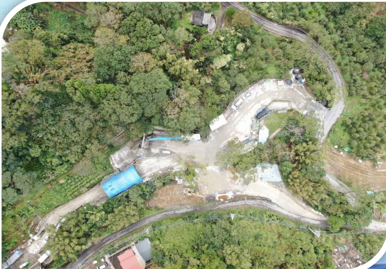
出口洞口: 出口空拍照。
