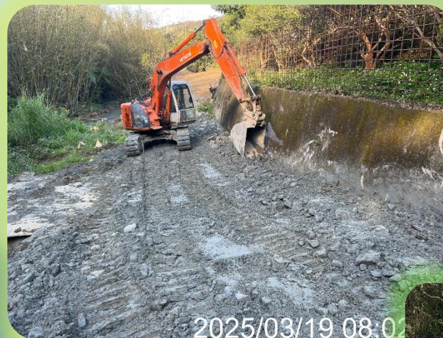
明挖段： 回填整地。
