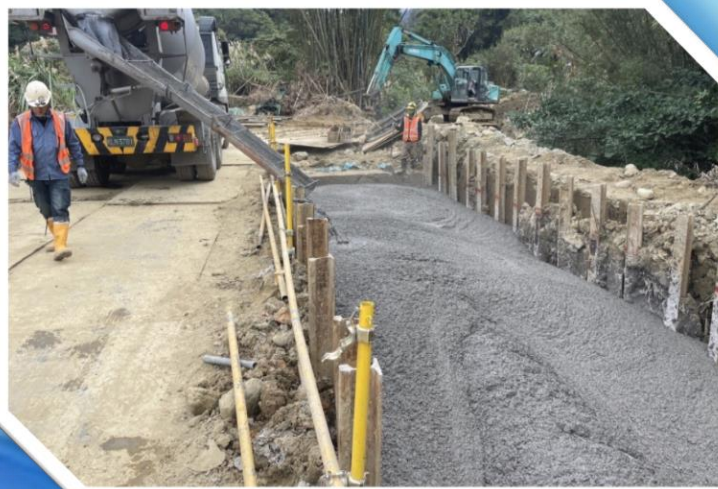
明挖段： CLSM回填。
