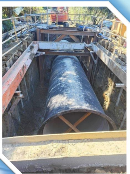
明挖段： 埋設DIP管。
