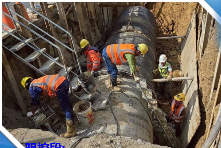
明挖段: DIP17-4埋設安裝。
