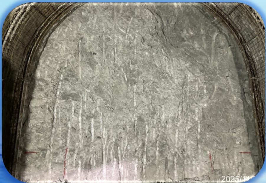
出口一般段: 出口端隧道ST-947開挖面照。
