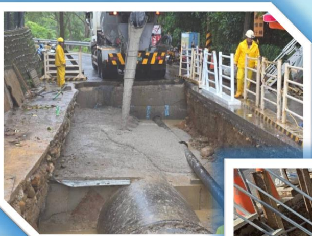
明挖段: CLSM澆置。
