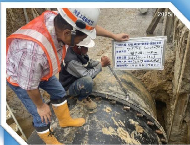
明挖段: 扭力值檢測。
