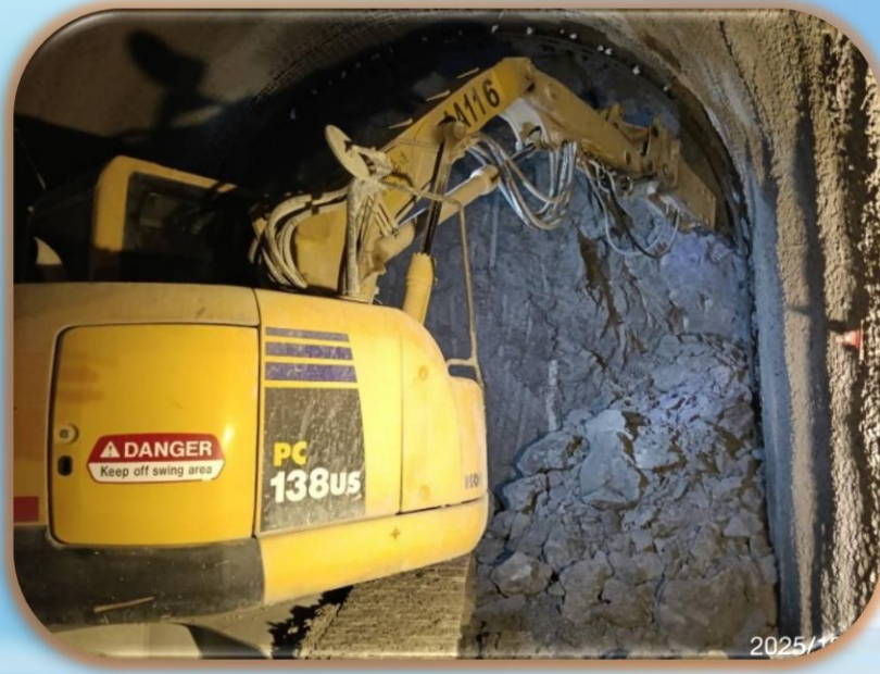
出口一般段: 出口端隧道開挖作業。
