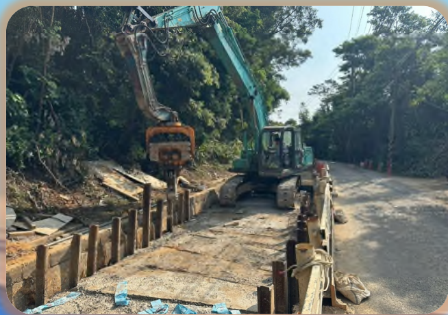
明挖段第一工作面： 鋼軌樁拔除作業
