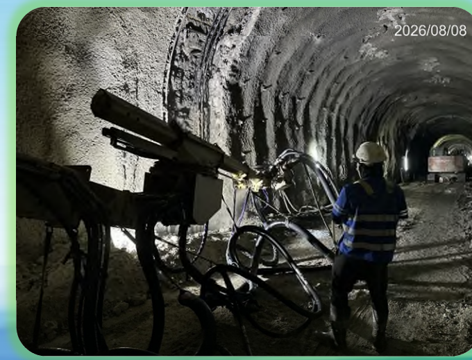
隧道段: 斷面入侵修改噴漿作業
