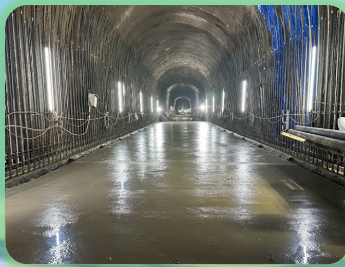
隧道段: 仰拱襯砌澆置完成面
