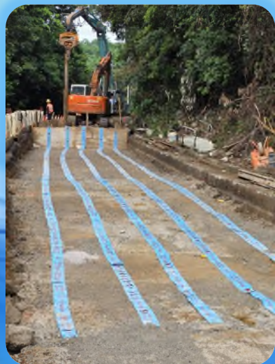
明挖段第一工作面： 警示帶鋪設
