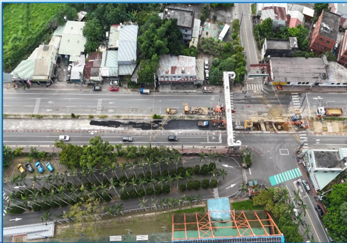
第二工區施工概況
