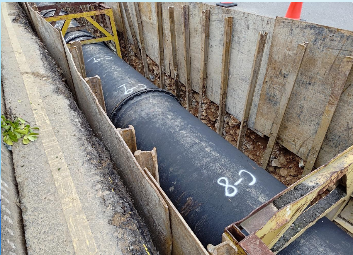
開挖後DIP管定位
