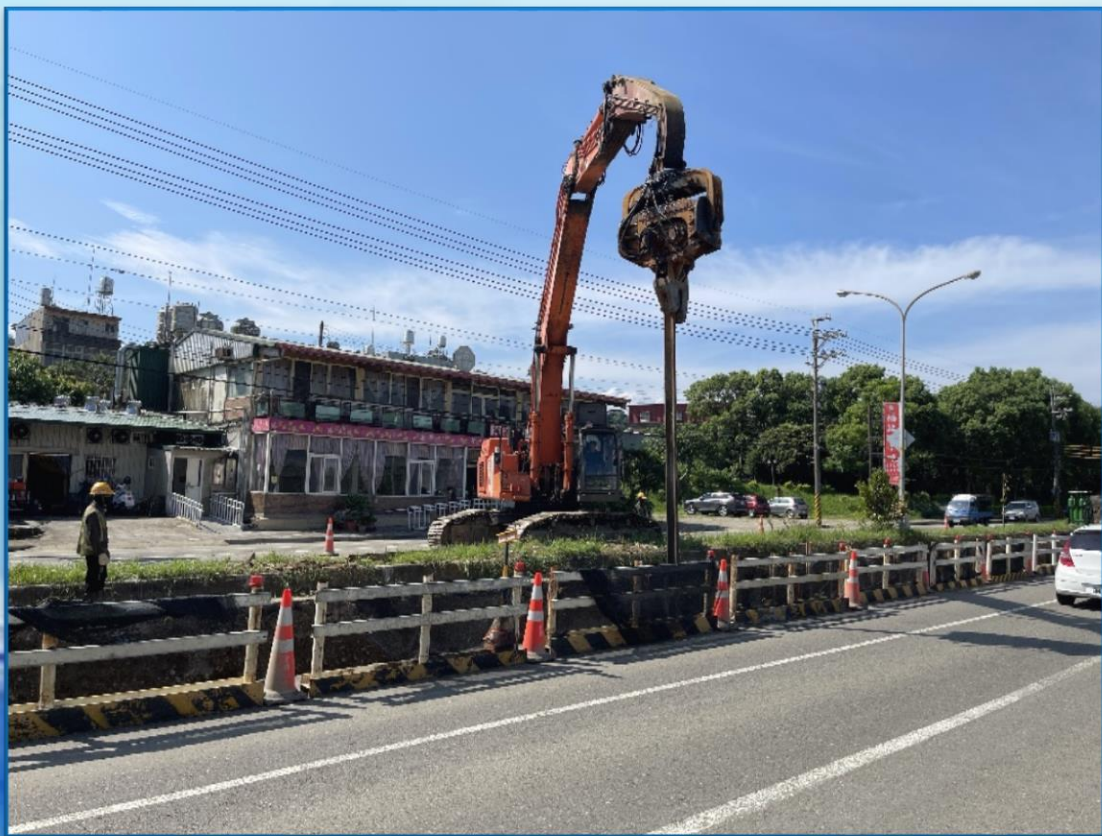
第一工區施工概況
