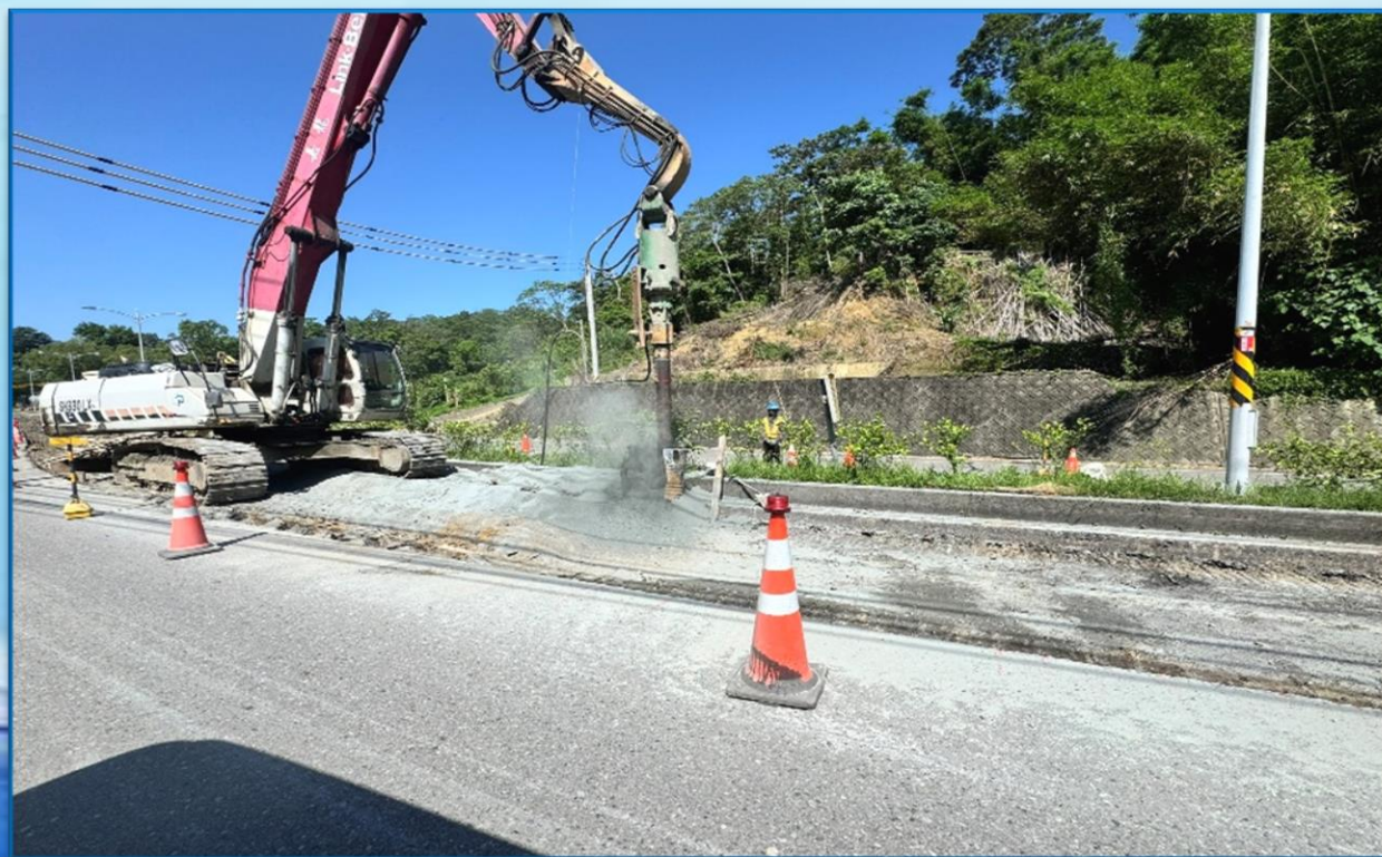
第四工區氣動錘鑽掘
