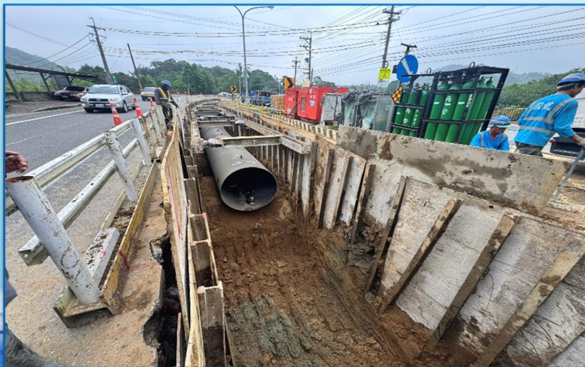
第一工區開挖埋管
