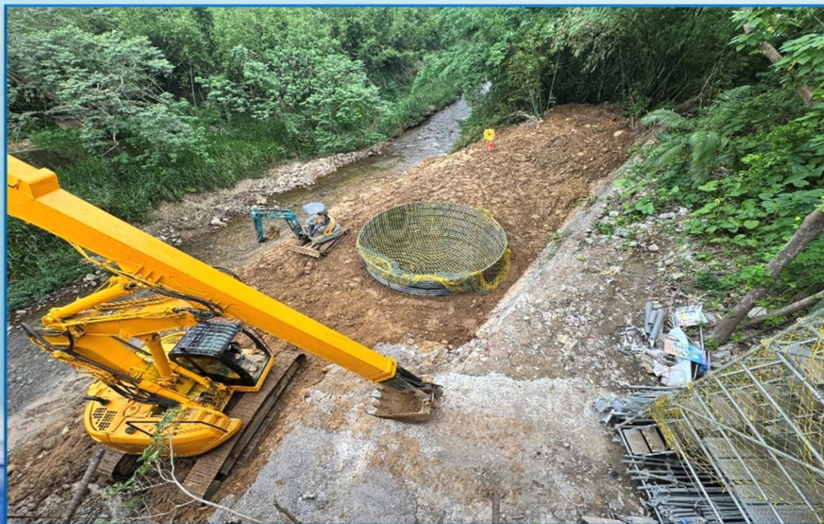
關西二號橋A1橋台整地
