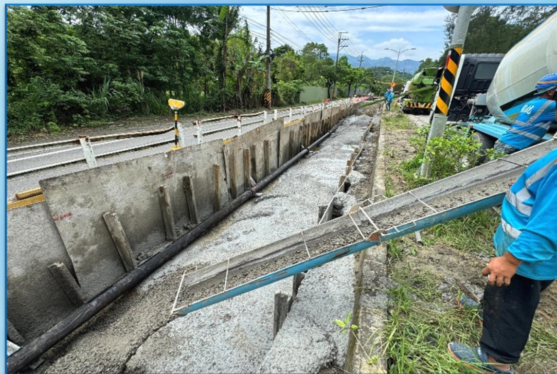
第四工區管溝回填
