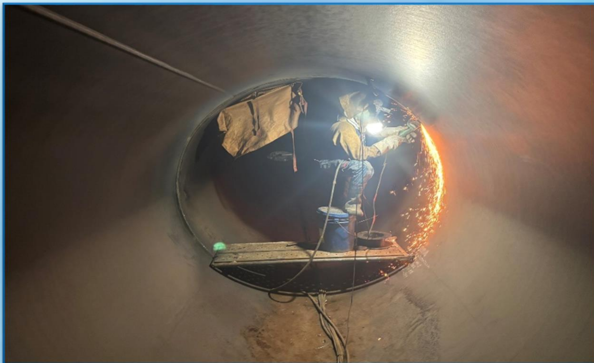
第一工區焊接作業
