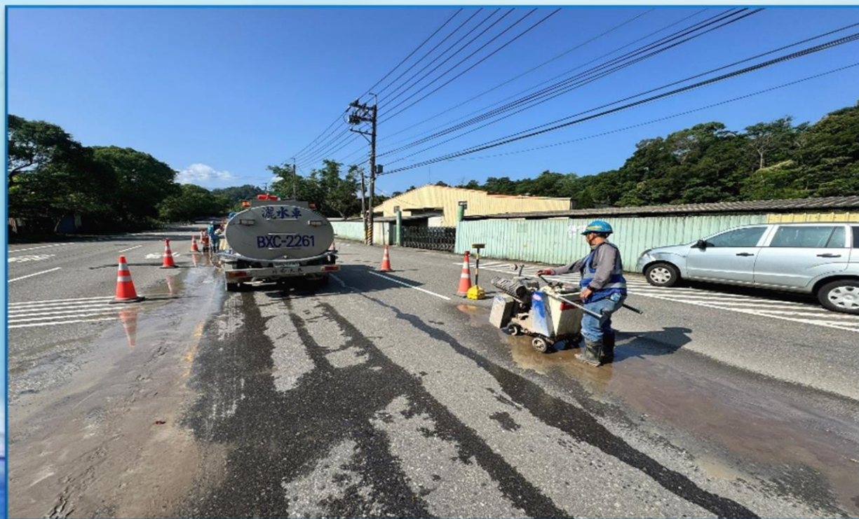
第三工區道路切割
