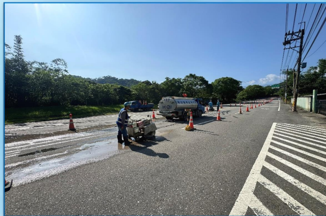
第三工區道路切割
