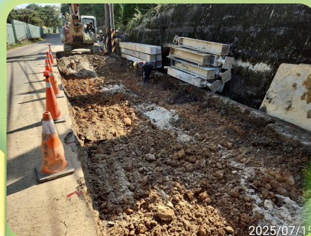
明挖段: 開挖路面AC剔除。
