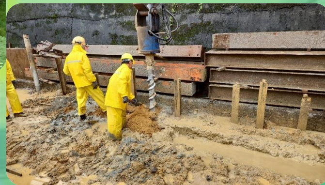
明挖段: 鋼軌樁引孔鑽設。
