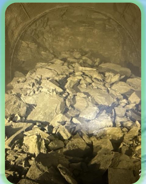
出口一般段: 出口端隧道開炸後開挖面。
