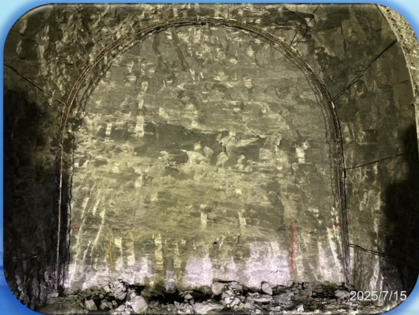
出口一般段: 出口端隧道ST-763開挖面照。
