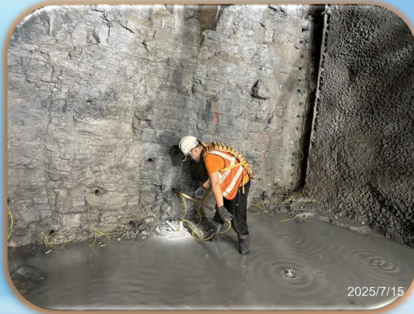
出口一般段: 出口端隧道裝設炸藥結線作業
