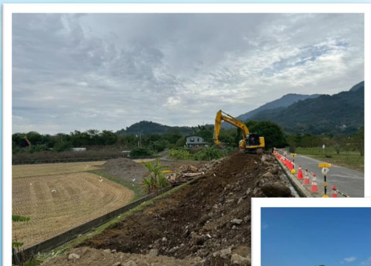
緩衝槽工區 工區整地
