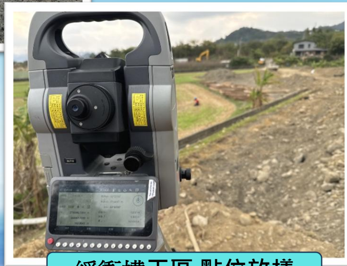
緩衝槽工區 點位放樣
