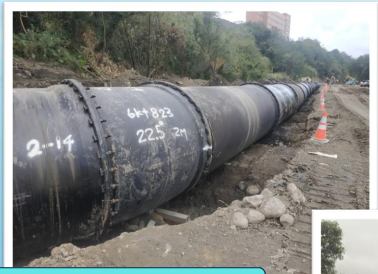
第二工區 管線安裝
