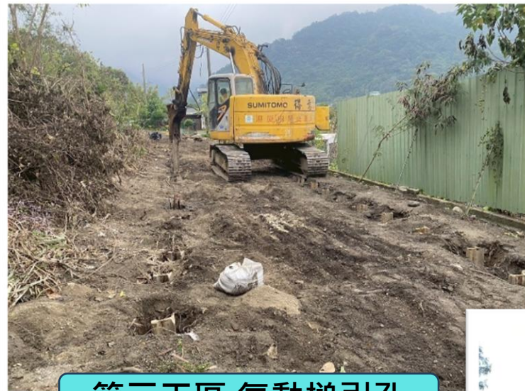
第三工區 氣動槌引孔
