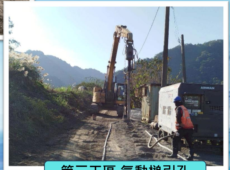
第三工區 氣動槌引孔
