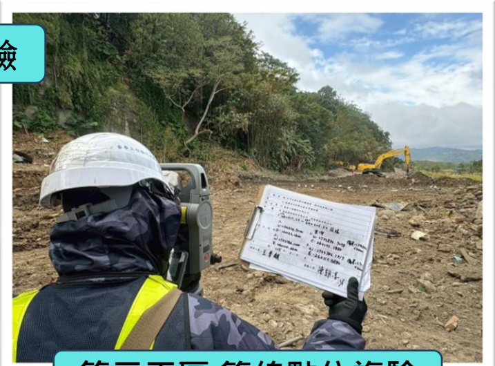
第二工區 管線點位複驗
