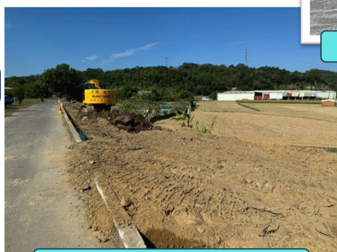
緩衝槽工區 工區整地
