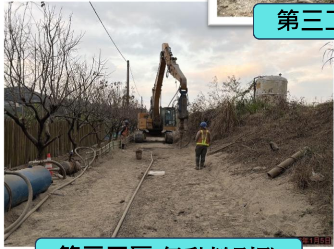
第三工區 氣動槌引孔
