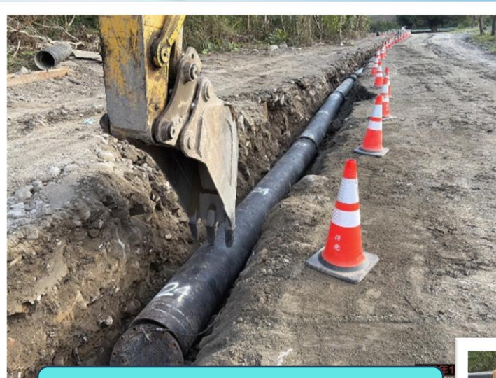
第一工區 伏流水復原
