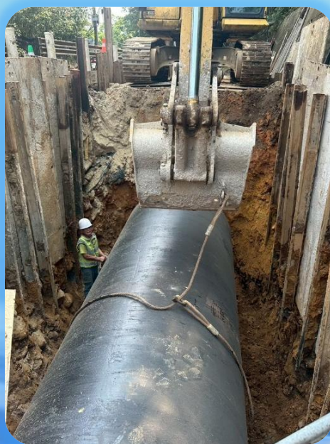
明挖段第一工作面: DIP埋設
