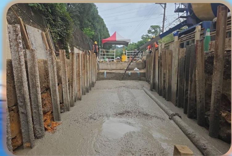
明挖段第一工作面: CLSM澆置
