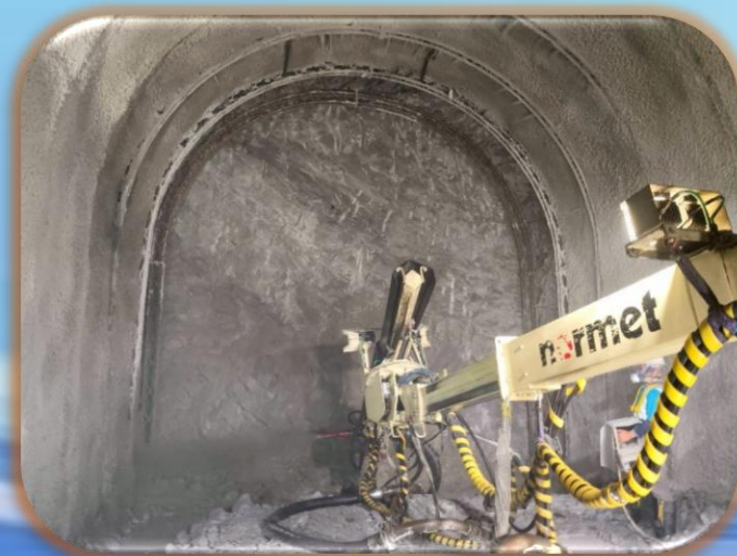
出口一般段: 出口端隧道噴漿作業
