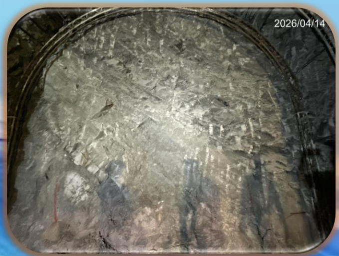
出口一般段: 出口端隧道ST-1250開挖面照
