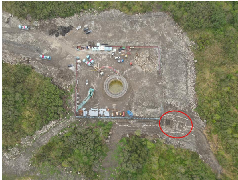
圖 4 已於集水井下游側設置臨時沉砂池(紅圈處)
