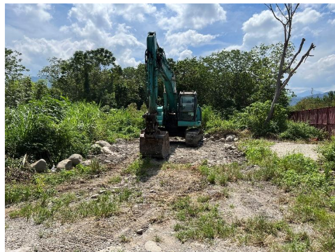
圖 2 施工便道、工程機具及原物料之堆置，迴避周邊植被(114/9/30)
