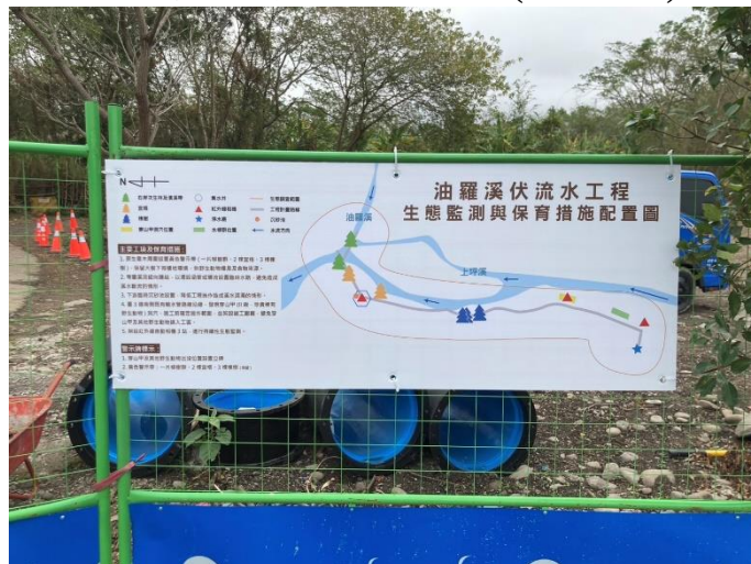
工區入口設置 1 處告示牌(113/12/20)
