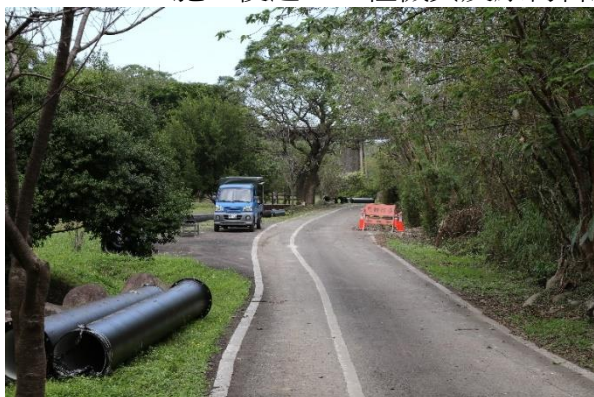
施工便道多使用既有道路(113/11/27)
