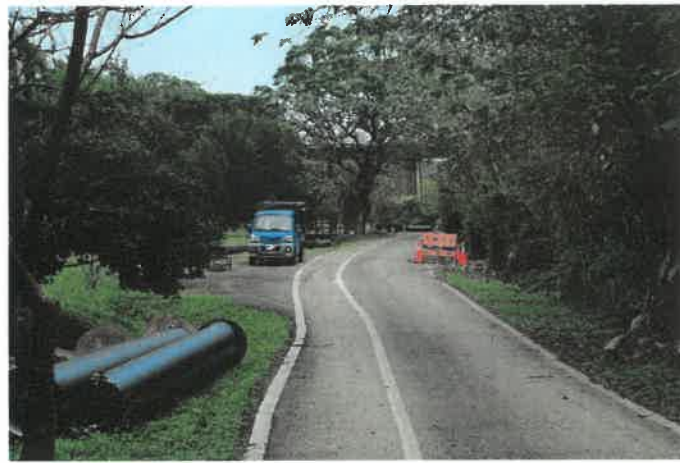
圖 3 施工便道多使用既有道路(113/11/27)
