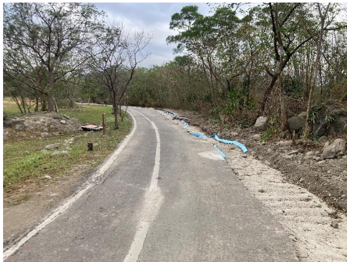
圖 3 施工便道多使用既有道路(113/12/20)
