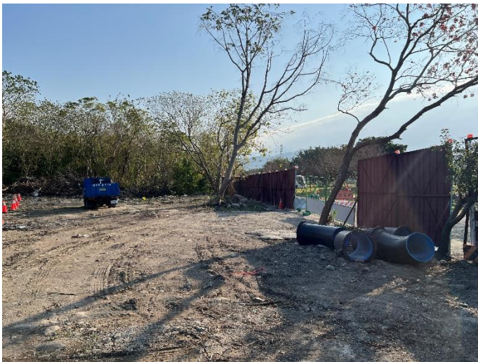
圖 2 施工便道、工程機具及原物料之堆置，迴避周邊植被(114/1/21)
