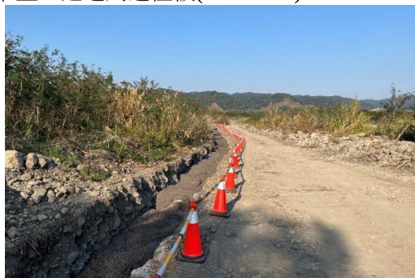
施工便道多使用既有道路(114/1/21)
