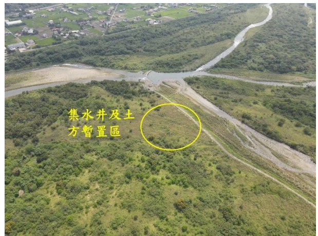
圖 1-5 集水井及土方暫置區現況圖
