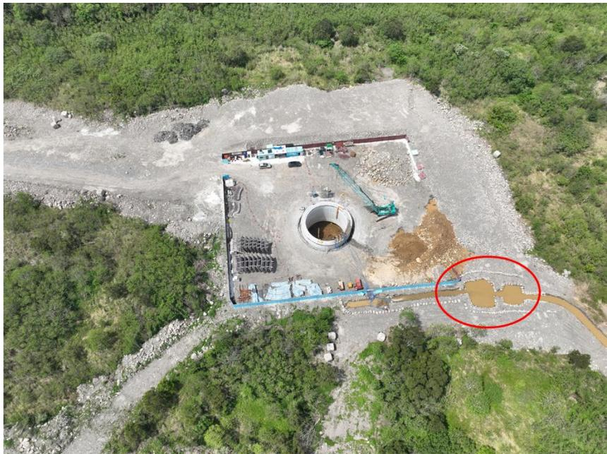
圖 4 已於集水井下游側設置臨時沉砂池(紅圈處)(114/3/27)
