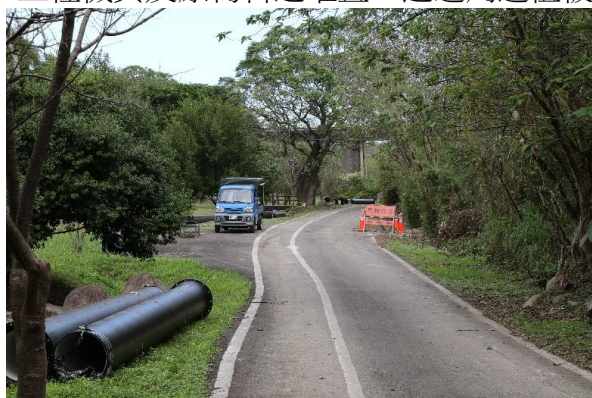
施工便道多使用既有道路(113/11/27)
