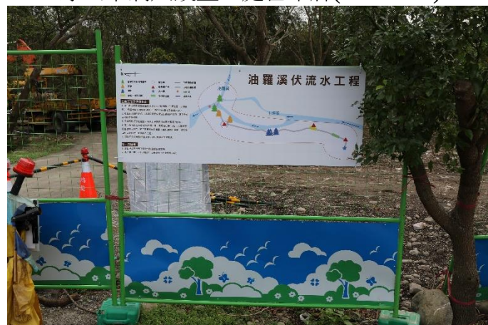
工區入口設置 1 處告示牌(113/11/27)
