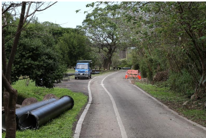
圖 3 施工便道多使用既有道路(113/11/27)
