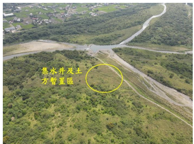
圖 1-5 集水井及土方暫置區現況圖
