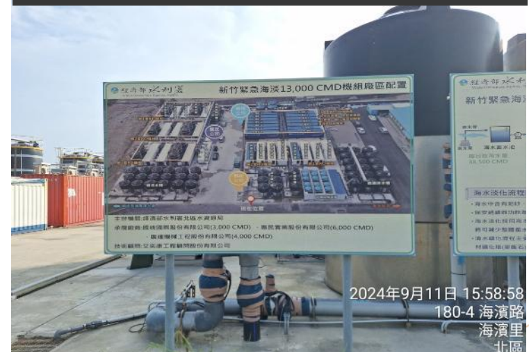
工區南側臨時海淡處理設施
