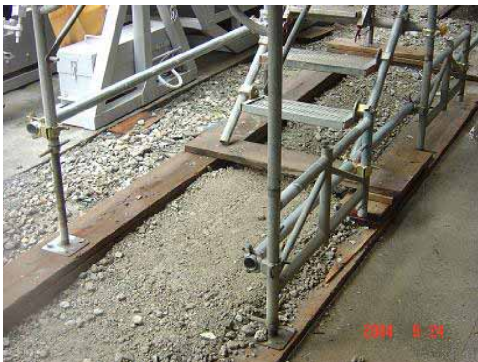
照片 5-2. 基礎地面應平整、夯實緊密、襯以適當材質之墊材，施工架底部之立架設可調型基腳座板，以避免產生不均勻沉陷。
