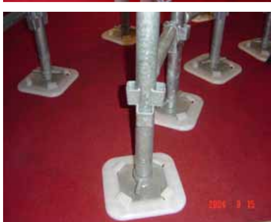
照片 5-1. 施工架腳部設置基座增加穩定性。
