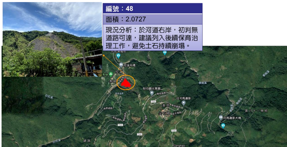
圖4-15 石門水庫集水區須關注之崩塌地位置(編號48)
