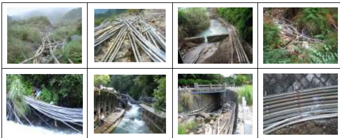
圖 5-8 陽明山國家公園地區引水管線佈設普遍情形之照片
