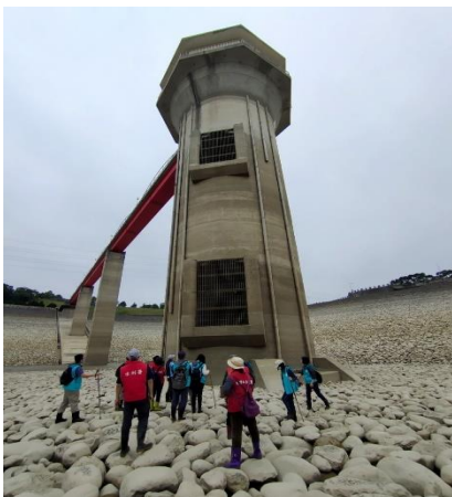
水庫實地瞭解(取水塔)
