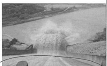
⑨ 颱風天豪大雨 水源混濁
