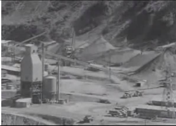
預拌混泥土場
