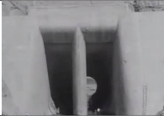
導水隧道進水口在大壩上游
