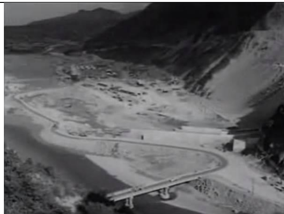
臨時通行橋，下面是南苑 後池 右下方有導水隧道，完工後，橋就沒了
