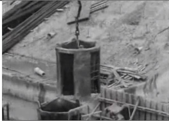
吊桶（裡面是水泥）
