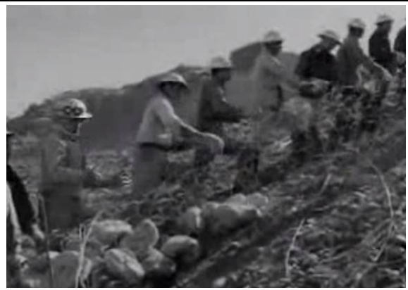
大壩位置，蛇籠在溢洪道底部，但葛樂禮颱風後 固結灌漿在鋪一米後水泥
