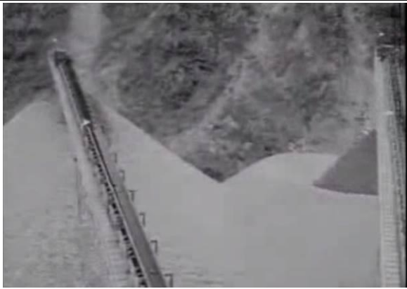
砂石場是大壩處施工隊、檢驗隊負責
