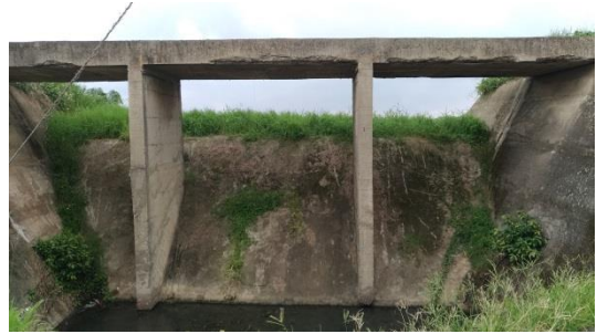
橫山大埤之溢水口
