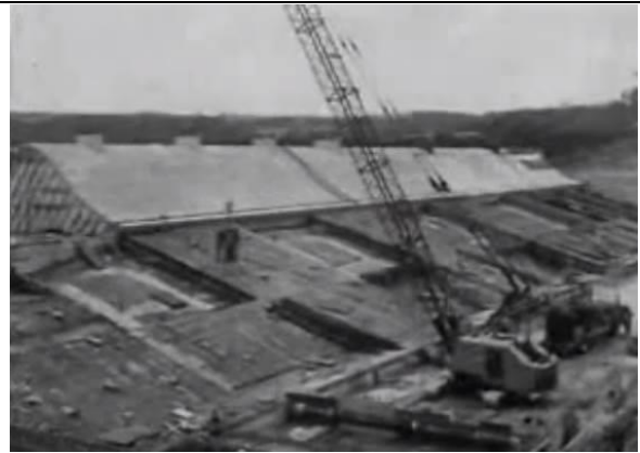
後池堰：右岸有斷層，所以沒有挖到基礎
