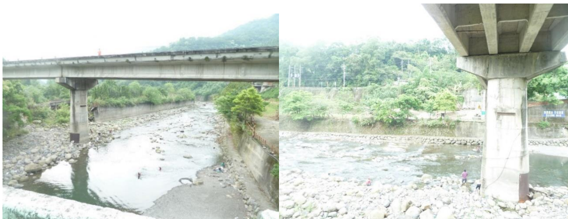
a.東眼橋現場流速量測
