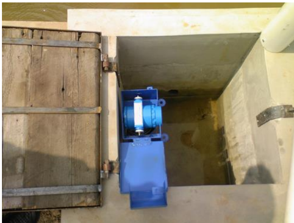
圖4-39電子水尺現地示意圖
