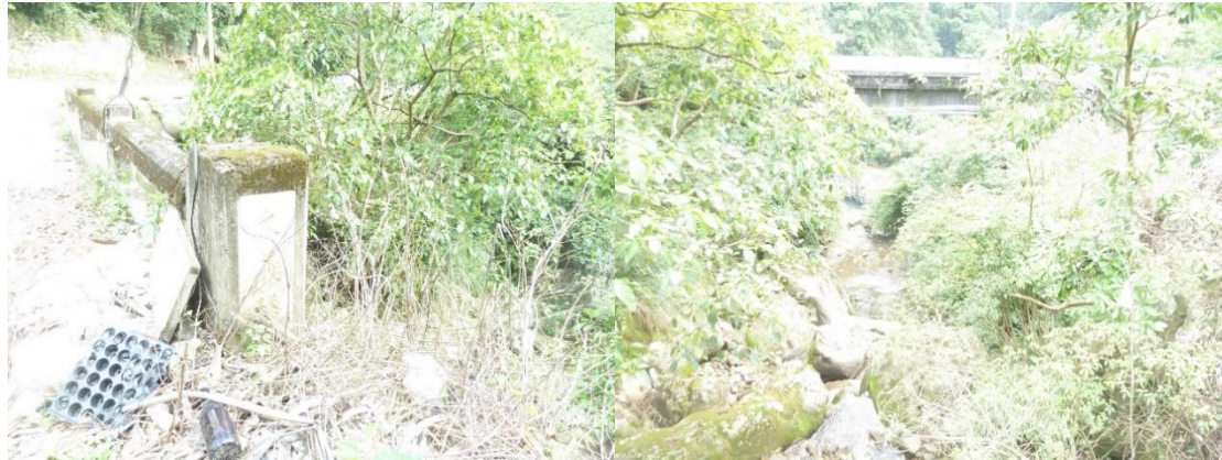
a.大義橋(舊) b.大義橋(舊)下之野溪
