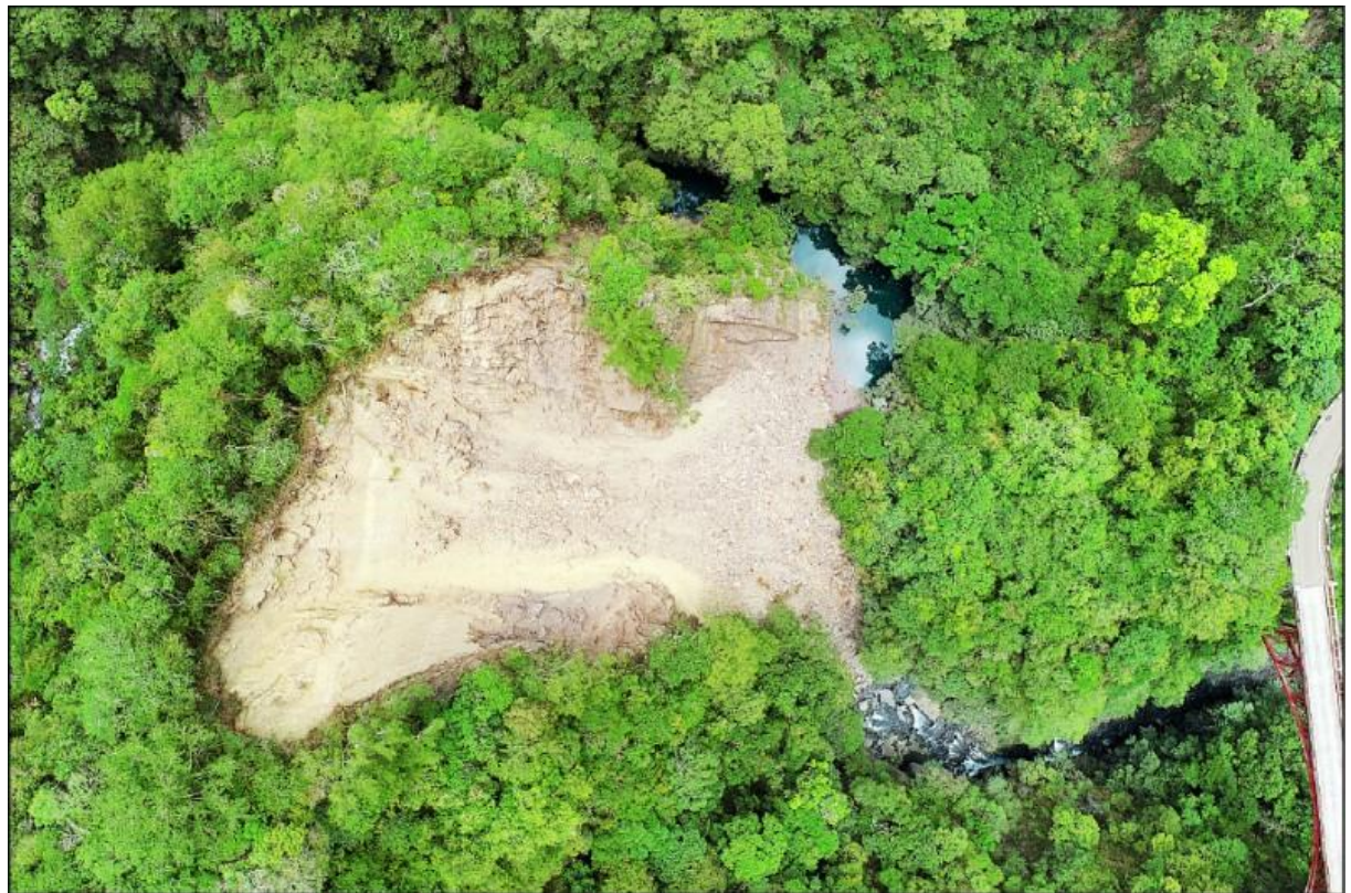
圖3-26 大曼溪崩塌堆積壩體與蓄水情形
