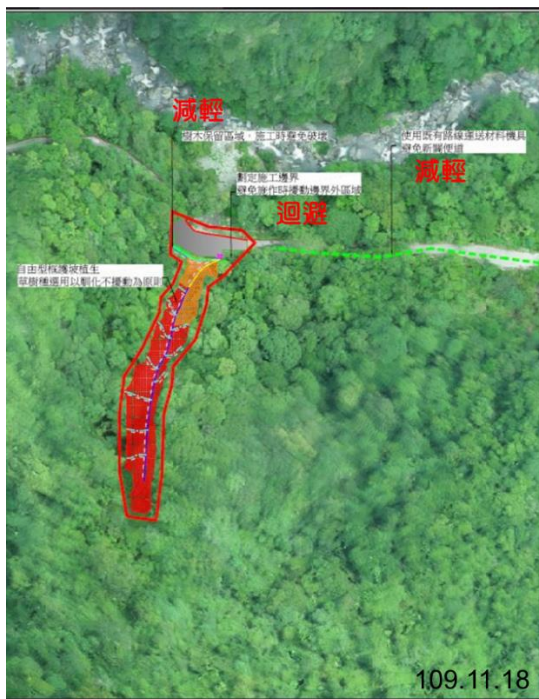
圖3-4 大溪 161 林班崩場地處理工程
