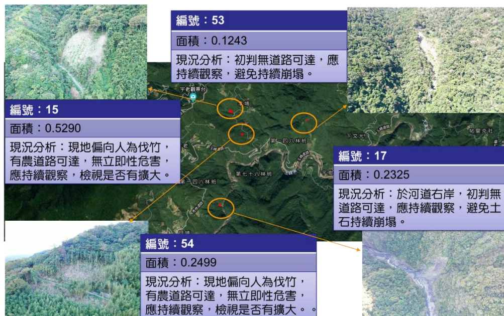
圖3-22 石門水庫集水區須關注之崩塌地位置(編號 15、17、53 及 54)
