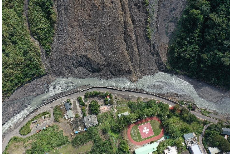
圖3-25 秀巒崩塌地 110 年 10 月 15 日空拍照(編號 48)
