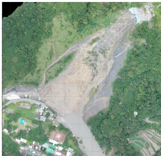
圖3-24 秀巒崩塌地 110 年 9 月 13 日空拍照(編號 48)
