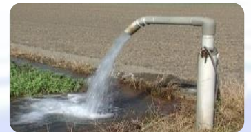
地下水及伏流水
