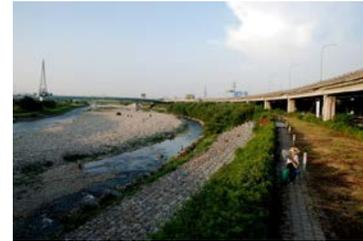
於衝擊力較小河段布設蛇籠、柳枝工等生態護岸
