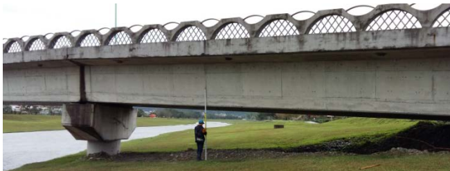
義隱橋（橋下淨高2.65m）
