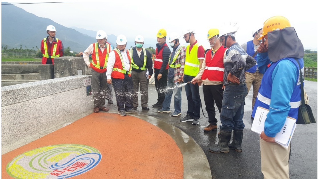
工地現場-透水鋪面測試
