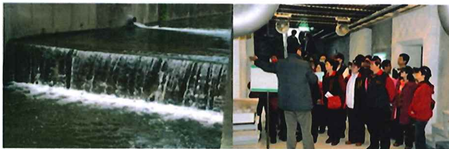
圖 4-1 以現地處理設施處理牛稠港溪水質(含污水截流工程)
