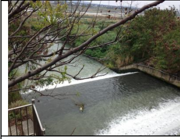
1、同安厝排水出口
