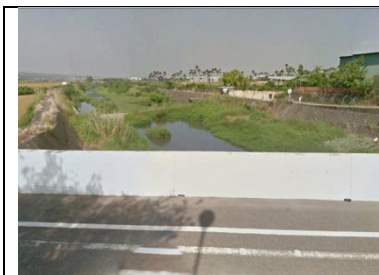
1、隘寮溪排水茄荖橋
