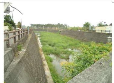
3、隘寮溪排水隘寮橋
