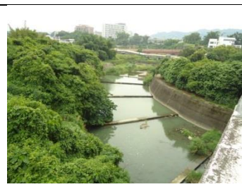
2、隘寮溪排水旭光橋
