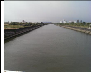
1、典寶溪排水通安大橋 下游段
