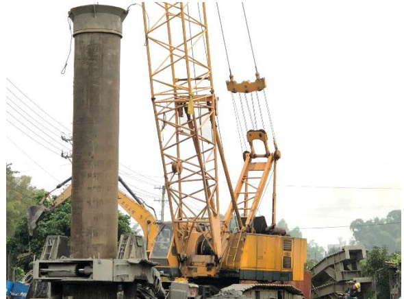
沙田水管橋：A2 橋台 基樁施作
