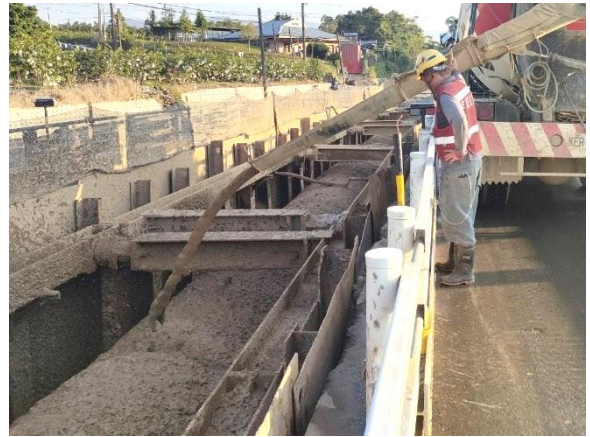
三埔段：21k+043~21k+119 第一次 CLSM (工地型拌合) 回填
