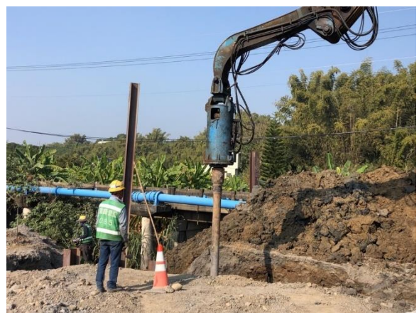
鏡面水庫水管橋：A2 橋台 擋土支撐打設
