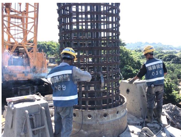
四埔水管橋：A1 橋台 基樁施作
