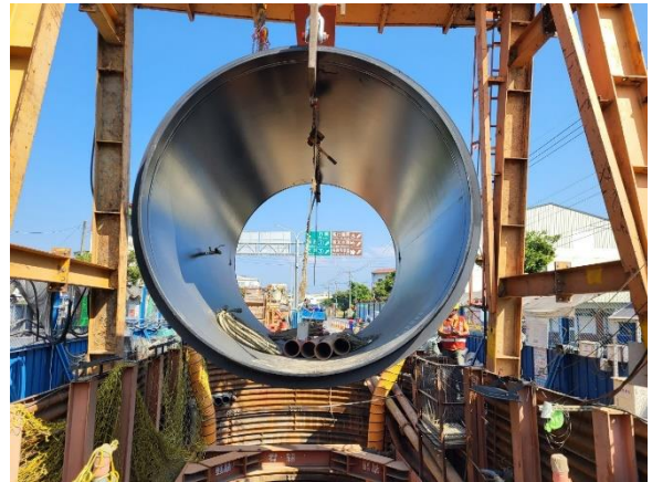
W41 工作井：推進工程施作
