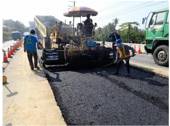
三埔段：21k+000~21k+121.6 瀝青鋪築
