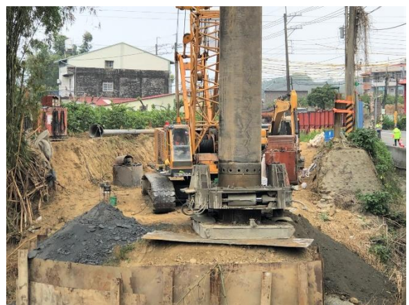
沙田水管橋：A1 橋台 基樁施作
