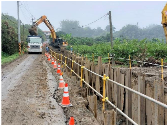
平壓管段：0k+324~0k+400 管溝開挖
