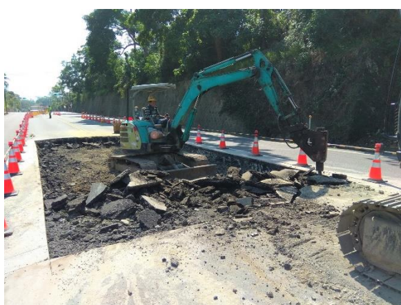
W52 工作井：工作井開坑作業
