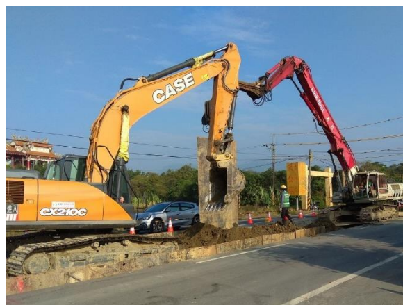
沙田段：20k+129~20k+251 擋土鋼板打設
