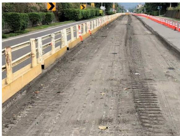
三埔段：22k+000~22k+240 瀝青刨除
