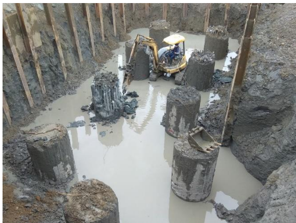
三埔水管橋：A2 橋台 樁頭打除
