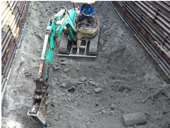
W52 工作井：工作井開坑作業
