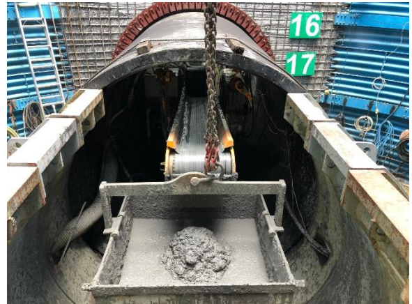
W59 工作井：推進工程施作
