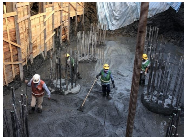
鏡面水庫水管橋：A2 橋台 澆置混凝土層
