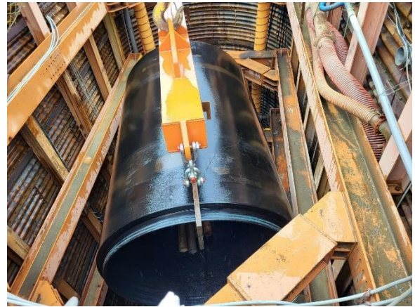
W41 工作井：推進工程施作
