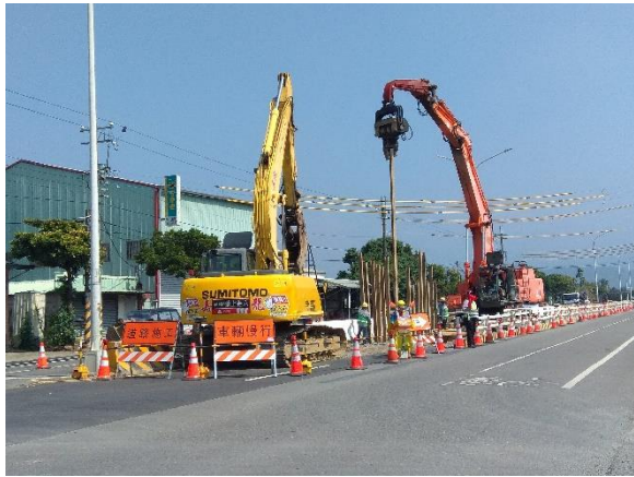
中正段：17k+339~17k+278 鋼軌樁打設
