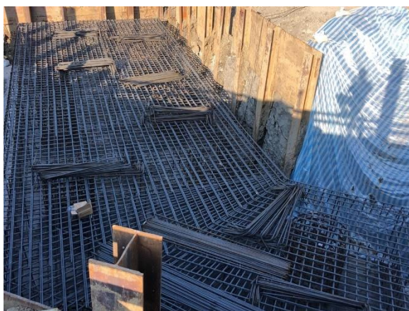
三埔水管橋：A2 橋台 基礎鋼筋綁紮
