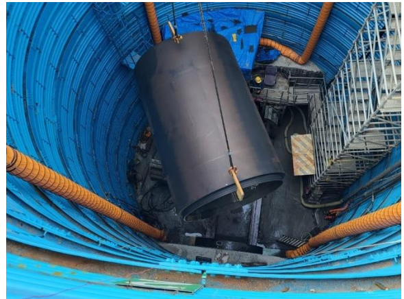
W59 工作井：推進工程施作
