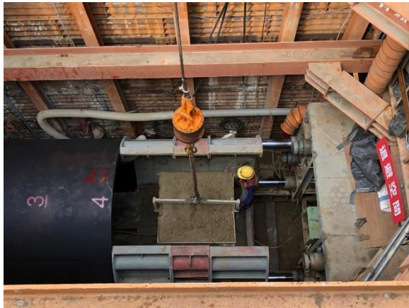
W43 工作井：推進工程施作
