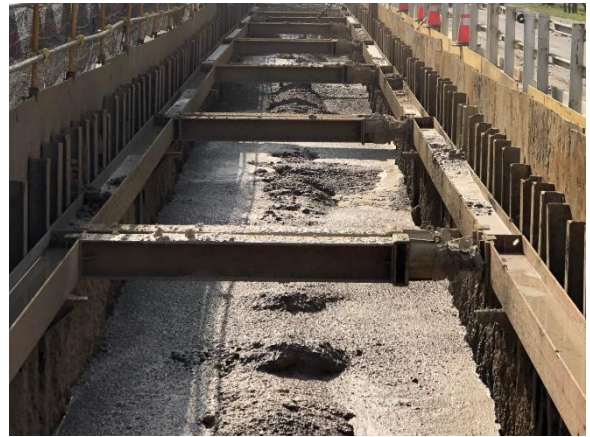
沙田段：20k+125~20k+187 第三次 CLSM (工地型拌合) 回填
