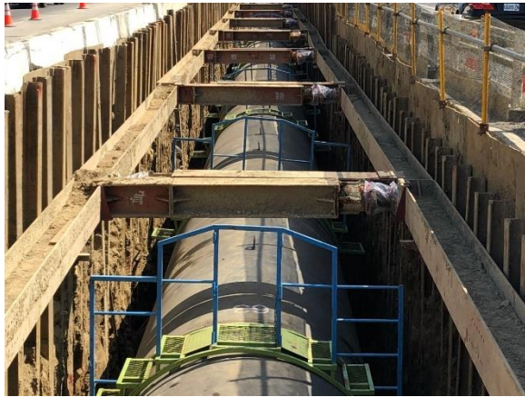
中正段：17k+278~17k+339 鋼管銲接
