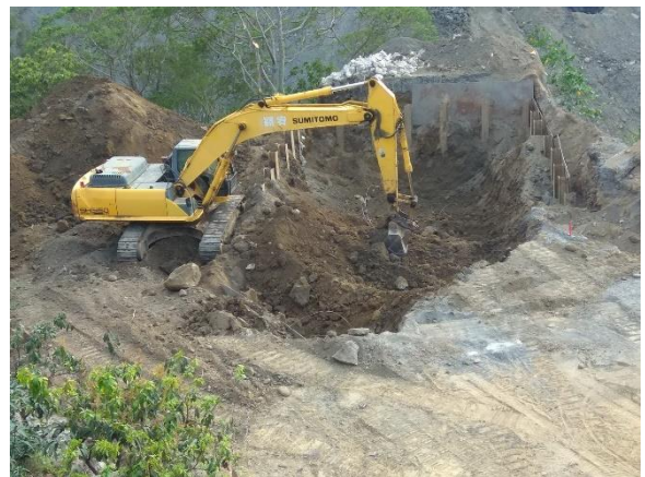
三埔水管橋：A1 橋台 開挖
