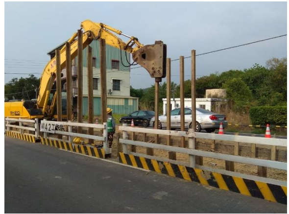
三埔段：22k+060~22k+180 鋼軌樁打設
