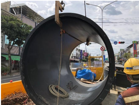
W43 工作井：推進工程施作
