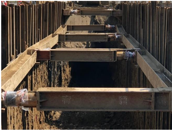
中正段：17k+217~17k+278 管溝開挖及水平支撐施作
