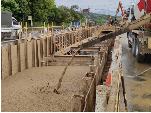
沙田段：20k+247~20k+293 CLSM (工地型拌合) 回填
