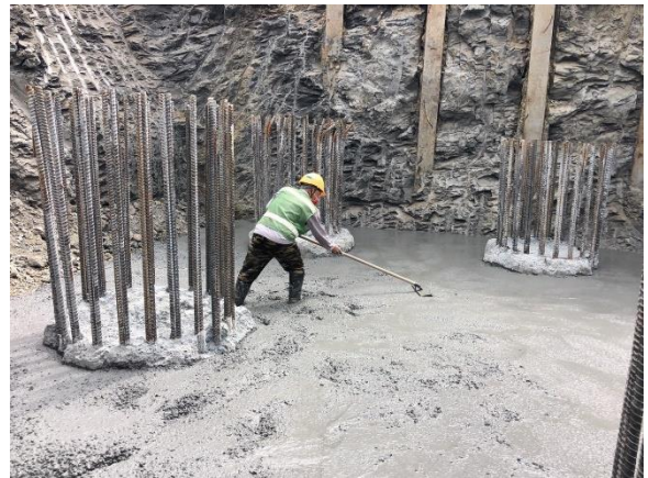
三埔水管橋：A1 橋台 澆置混凝土
