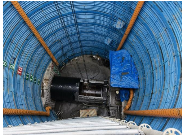
W59 工作井：推進工程施作
