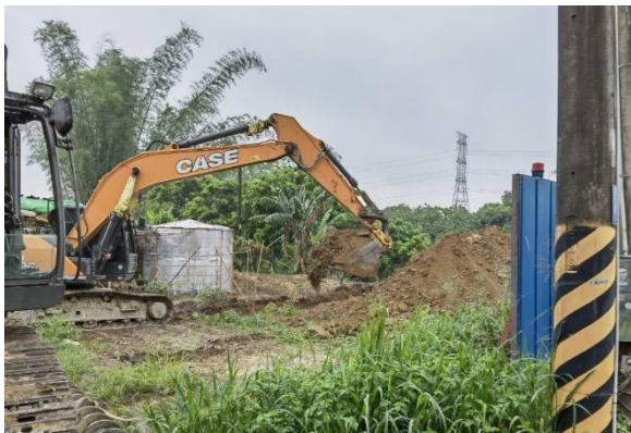
沙田水管橋：A2 橋台 開挖
