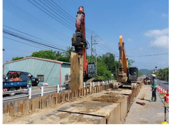
三埔段：21k+997~22k+058 擋土鋼板打設
